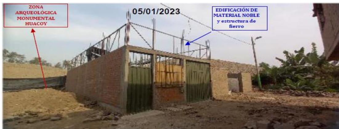
Foto 4: Zona Arqueológica Monumental Huacoy. Vista panorámica de la edificación de material noble (en color azul), localizada al interior de la poligonal intangible (en color rojo). Nótase sobre la cabecera de los muros de ladrillo una estructura de hierro. Tomado del Informe Técnico N° 000005-2023-DCS-MRC/MC y foto tomado el 05 de enero de 2023.
