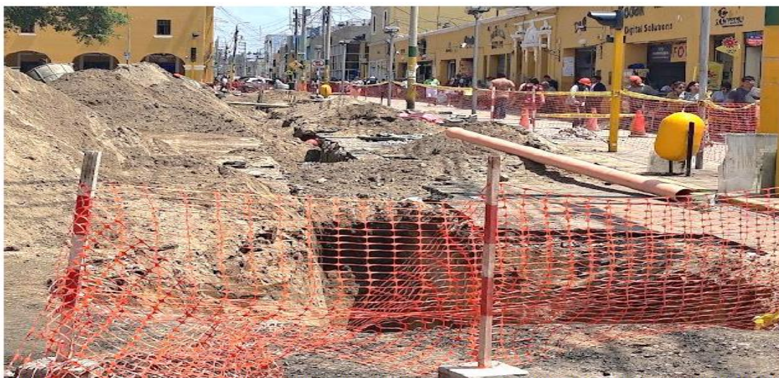
IMAGEN 06: Vista de la obra de excavación ejecutada en el centro de la vía vehicular con maquinaria pesada, de aproximadamente 1.00 m. de ancho.
