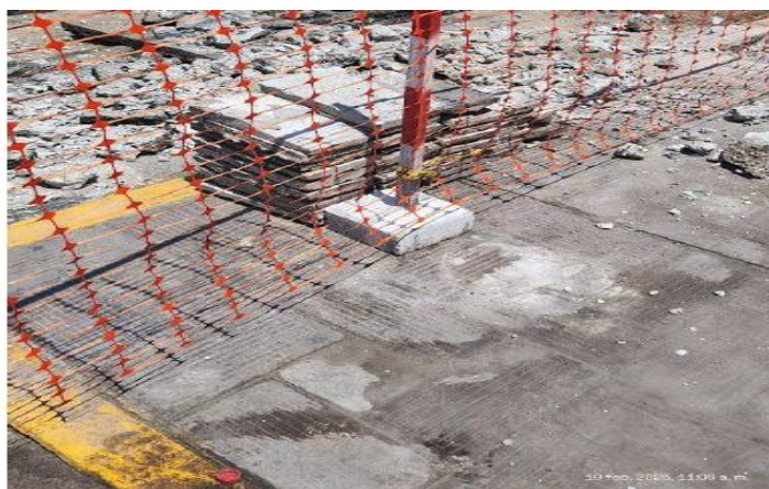
IMAGEN 11: Vista del cumulo de las bloquetas desmontadas de la vereda, previamente a la ejecución del corte con rotomartillo.
