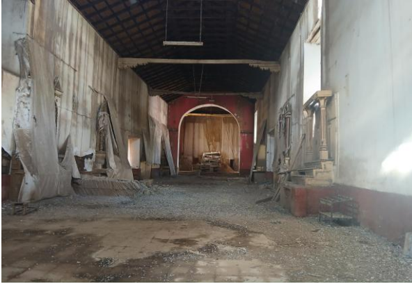
Vista de la nave desde el muro de pies
