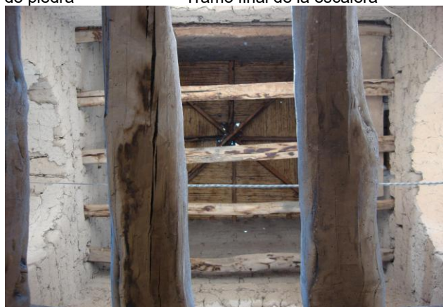
Estructura de madera rolliza en el nivel de base del cuerpo de campanas, en un sentido, y otro en el nivel de la base del vano que alberga al reloj
