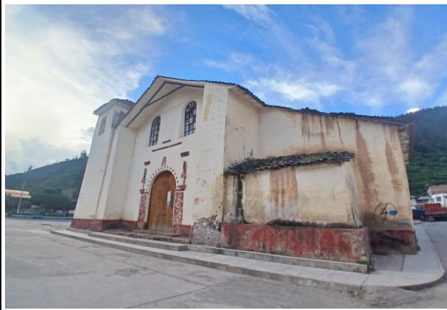
Muro de pies
