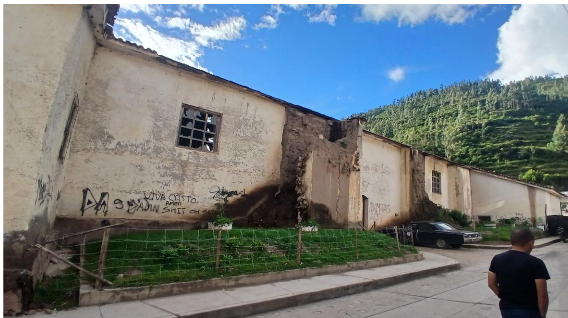
Muro de la Epístola
