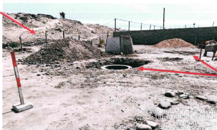
Foto 1: Imagen de fecha 24 de abril del 2025, en ella se aprecia dos de los pozos excavados y una estructura circular de concreto que sería parte del sistema del sistema de desagüe.
