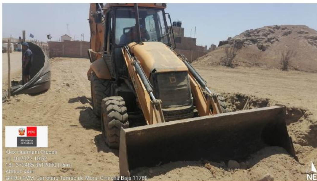
Imagen 02: vista de la maquinaria pesada registrada al momento de la intervención por parte del personal del Área de la Sub Dirección De Patrimonio Cultural Industrias Culturales E Interculturalidad del Ministerio de Cultura Ica. ( Registro Fotográfico: 11/10/2022)
