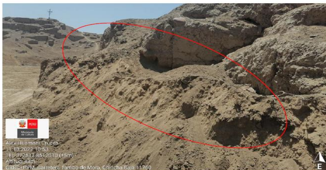
Imagen 11: vista a detalle de la destrucción de un segmento de muro de tapia, producto de la excavación con la maquinaria pesada. Una afectación directa a los restos arquitectónicos del sitio arqueológico. ( Registro Fotográfico: 11/10/2022)
