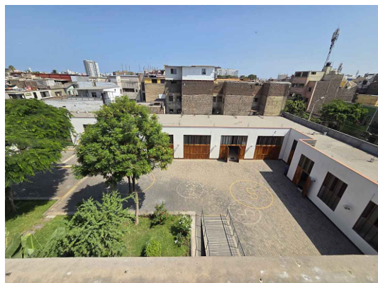
Vista del patio posterior.
