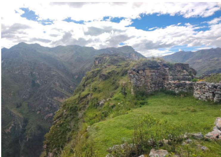
Imagen 02. Vista de estructuras del sitio de Ichugan, nótese abundante maleza que es quemada en temporada seca.
