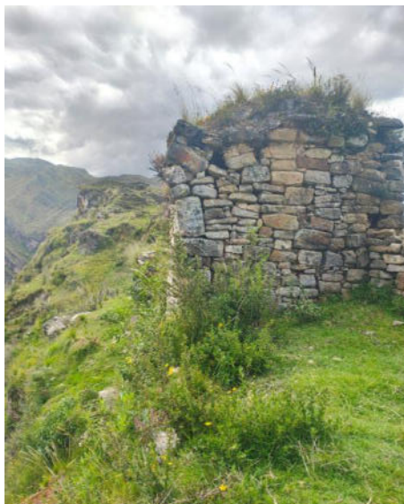
Imagen 01. Vista de estructura de planta rectangular del sitio arqueológico de Ichugan.
