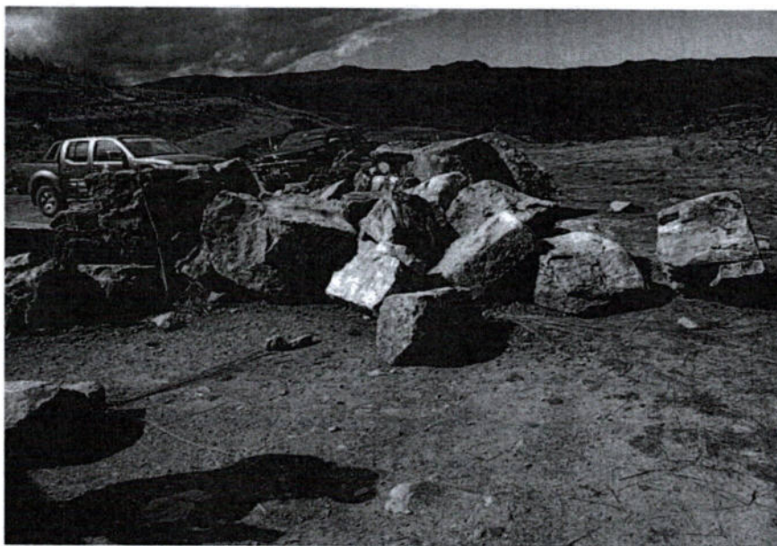
Imagen 3: AFECTACION 1, vista de amontonamiento de bloques grandes de piedra (inspección 22/06/2026)
