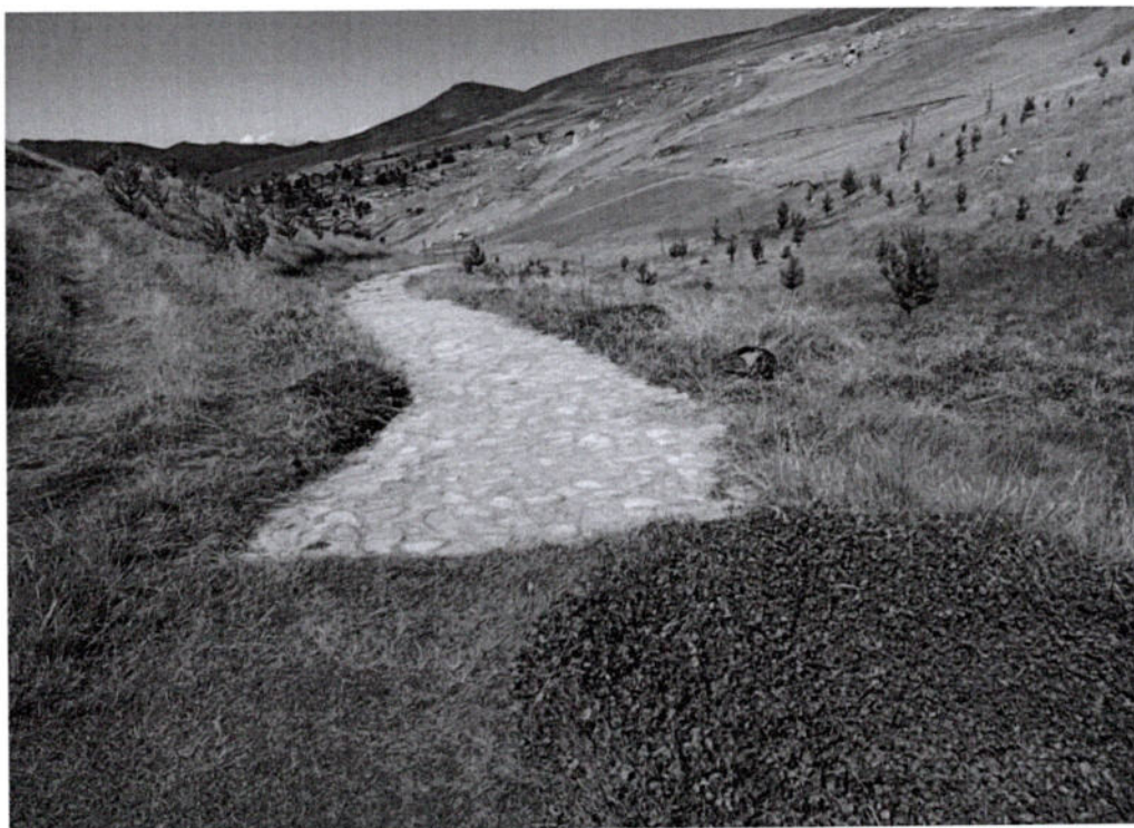
Imagen 2: Vista sobre la construcción del camino peatonal donde se emplearon piedras y cemento en la calzada (inspección: 22-06-2026).
