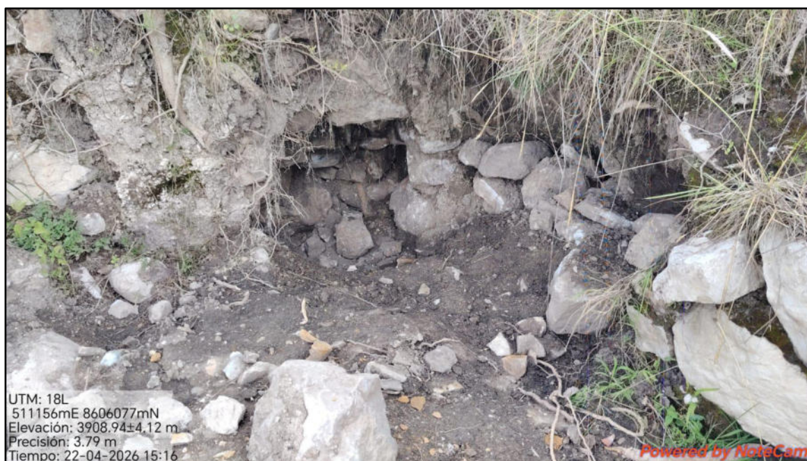
Imagen N° 06: Vista de la remoción intencional de la base de las calzadas, donde se visualiza la parte inferior del muro. Es por ello la necesidad de establecer la protección provisional del sitio, mientras se encuentre en proceso de aprobación y divulgación de su reconocimiento.
