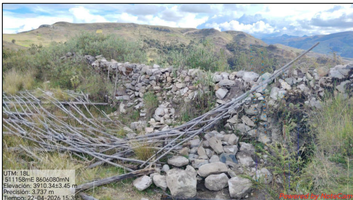
Imagen N° 05: Vista de uno de los muros dentro del polígono del Complejo Arqueológico, donde se evidencia el colapso parcial de los muros, estos hechos se encuentran registrados y oficializados para el proceso PAS.
