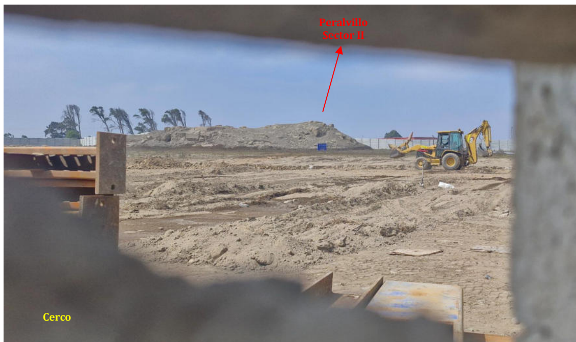
Foto 5: Sitio Arqueológico Peralvillo – Sector II. Vista del interior del predio de propiedad de la Empresa AGROMAR INDUSTRIAL la (en color amarillo), con relación al bien arqueológico (en color rojo). Nótese a una maquinaria nivelando el terreno. Foto tomada el 30 de abril de 2026.
