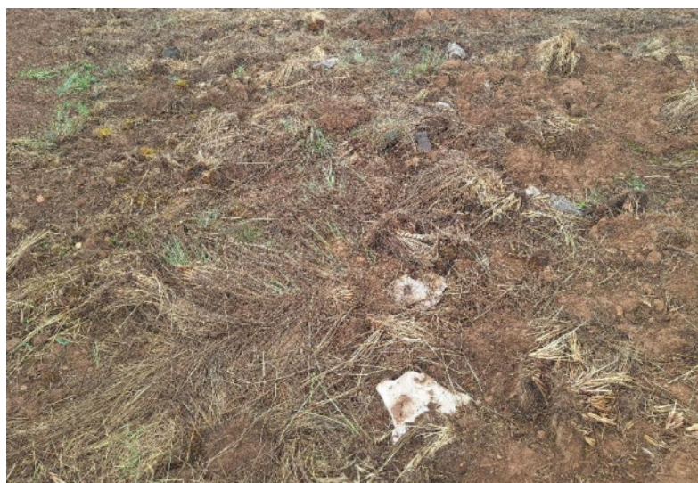
Foto. 5: vista del Qhapaq ñan afectado donde se evidencia piedras sueltas que son parte de la delimitación de la calzada.
