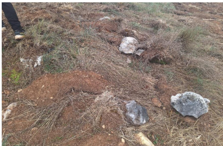
Foto. 3: vista de la calzada del Qhapaq ñan afectado, donde se evidencia piedras sueltas las cuales son parte del muro de delimitación de la calzada.
