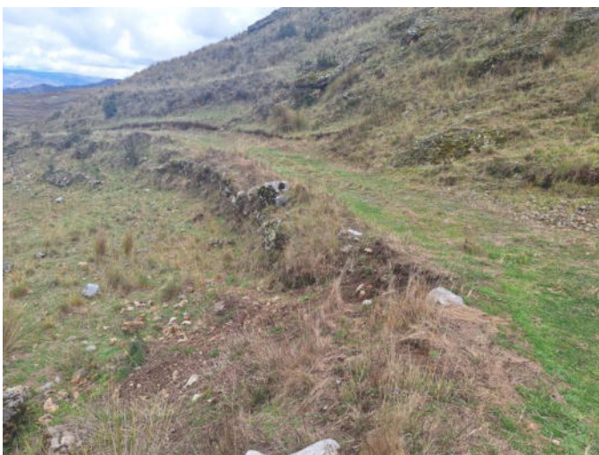
Foto. 13: vista de muro de contención y calza del camino prehispánico.
