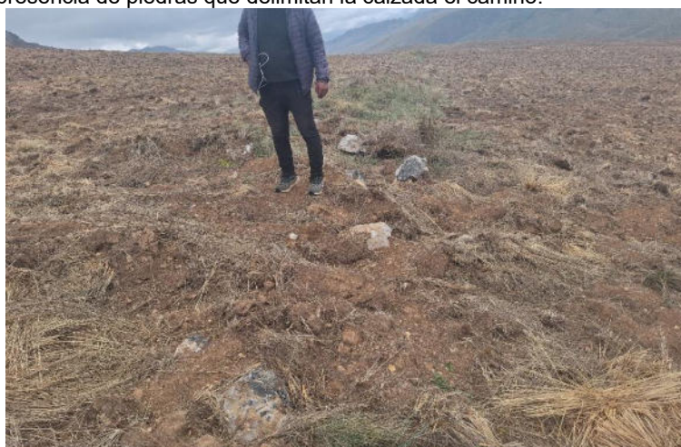
Foto. 2: vista de la calzada del Qhapaq ñan afectado, donde se evidencia piedras sueltas las cuales son parte del muro de delimitación de la calzada.
