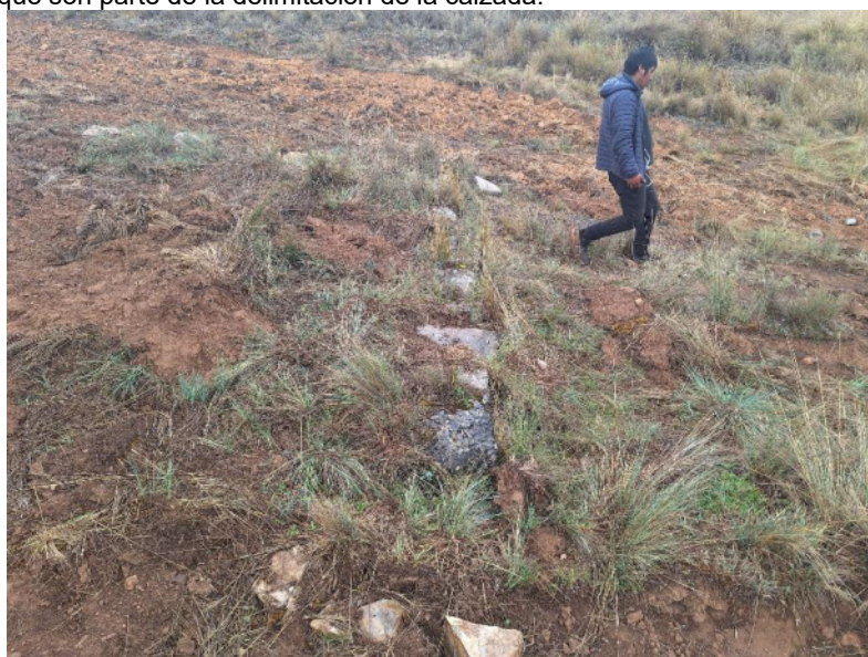
Foto. 7: vista de las escalinatas las cuales fueron destruidos casi en su totalidad.
