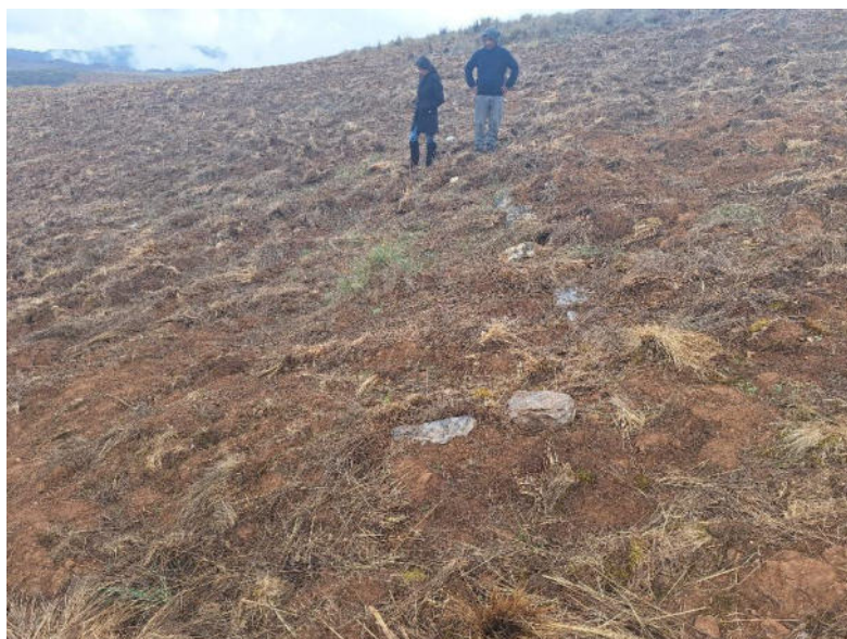
Foto. 6: vista del Qhapaq ñan afectado donde se evidencia piedras sueltas que son parte de la delimitación de la calzada.
