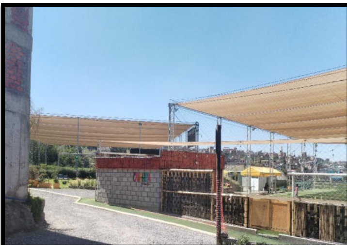
Foto N° 12, en el cual se puede visualizar que los espacios agrícolas vienen sufriendo modificaciones para diferentes usos (canchas sintéticas)
