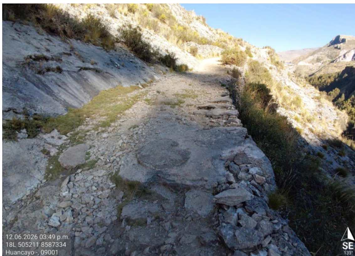
Fotografía 14. Vista panorámico de un sector del camino prehispánico de tipo plataforma, con muro de sostenimiento de piedra pircada, adosada a área rocosa.
