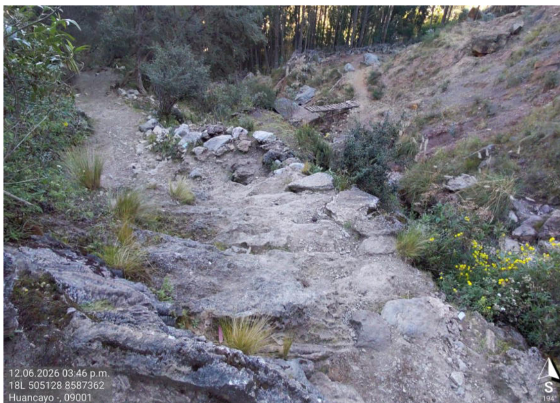
Fotografía 12. . Vista panorámico de un sector del camino prehispánico que presenta una calzada excavada en roca, con muros de sostenimiento de piedra.
