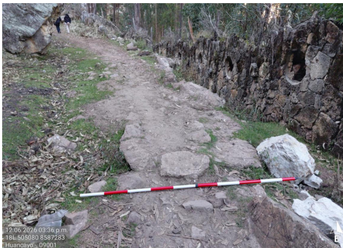
Fotografía 6. Vista a detalle de un canal de drenaje en el camino prehispánico.
