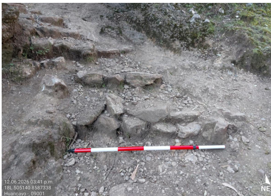
Fotografía 10. Vista del detalle constructivo del camino prehispánico que presenta escalinas.
