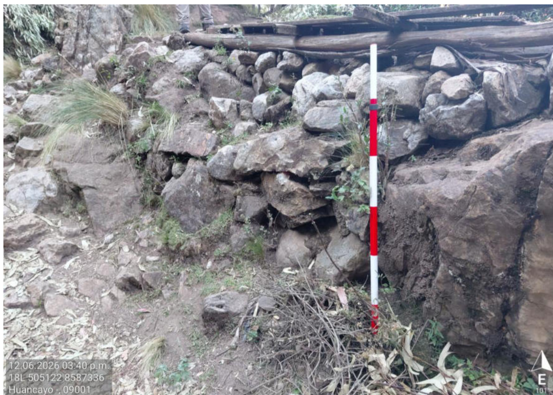
Fotografía 9. Vista a detalle de las bases de un puente sobre una pequeña quebrada, estribo B.
