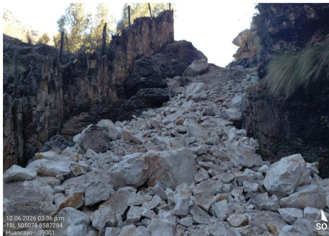
Fotografía 4. Vista de la calzada del camino rocosa afectado por la apertura de la trocha, cerca del polígono de Paturpampa.
