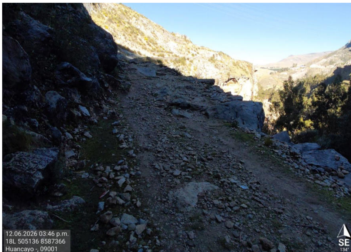
Fotografía 13. Vista panorámico de un sector del camino prehispánico de tipo plataforma, con muro de sostenimiento de piedra pircada, adosada a área rocosa.
