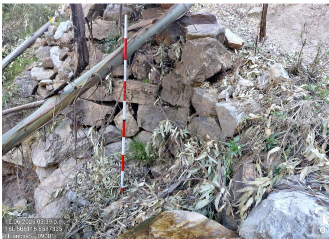
Fotografía 8. Vista a detalle de las bases de un puente sobre una pequeña quebrada, estribo A.
