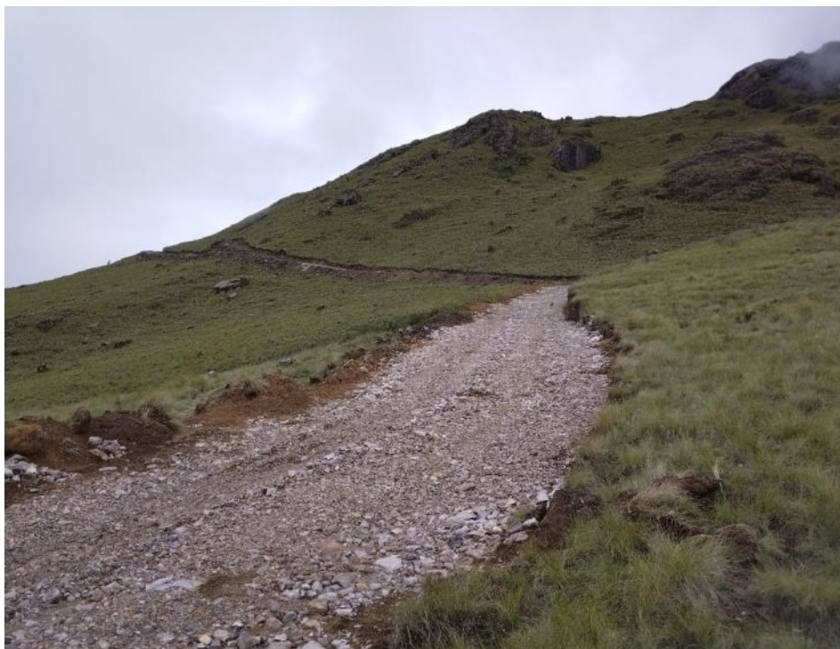
Fig. Vista Panorámica de parte del acceso habilitado para llegar a un área destinada posiblemente para la explotación minera. La continuación de los trabajos no autorizados afectaría a la evidencia arqueológica presente en el lugar, pertenecientes al Sitio Arqueológico "Huaylio".
