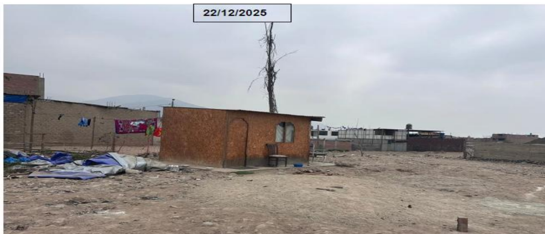
Foto 2. Zona Arqueológica Monumental Huacoy. Se aprecia el asentamiento "construcción" de 01 edificación precaria de madera, caseta pre fabricada de madera de tableros de OSB, previa remoción de terreno. Nótese que se encuentra en el mismo estado. Foto tomada el 22 de diciembre de 2025.
