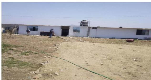
Imagen 31. Corresponde a la Diligencia Fiscal e inspección de fecha 25.01.2024 del Informe N°000034-2024-PCDPC-SDDPCIGI-DDC LIB-EGT/MC de fecha 01.03.2024. Imagen 21. Vista panorámica de una vivienda elaborada a base de concreto (ladrillo y cemento) cubierto con techo de calamina y con ventanas de vidrio, así como un tanque elevado de agua de polietileno, ubicado dentro del polígono de intangibilidad del Complejo Arqueológico Chan Chan, lo señalado a sido señalado en la página 4 párrafo segundo del acta de la Verificación Fiscal
