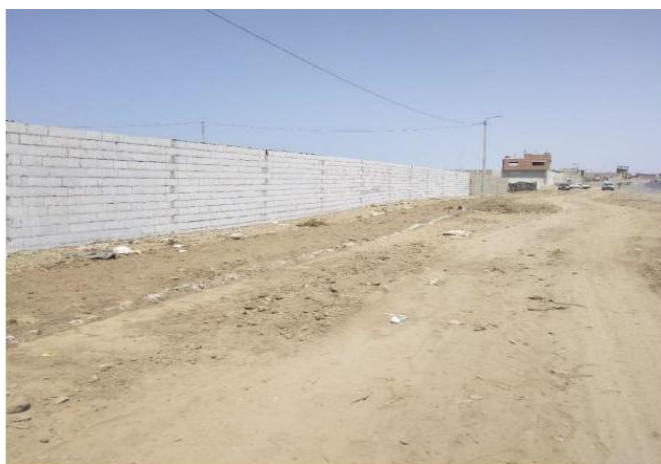
Imagen 20. Corresponde a la Diligencia Fiscal e Inspección de fecha 25.01.2024 del Informe N°000034-2024-PCDPC-SDDPCICI-DDC LIB-EGT/MC de fecha 01.03.2024 Imagen 09. Vista panorámica del cerco perimétrico elaborado a base de ladrillo de cemento, y columnas de concreto (fierros y cemento) y pintado de
