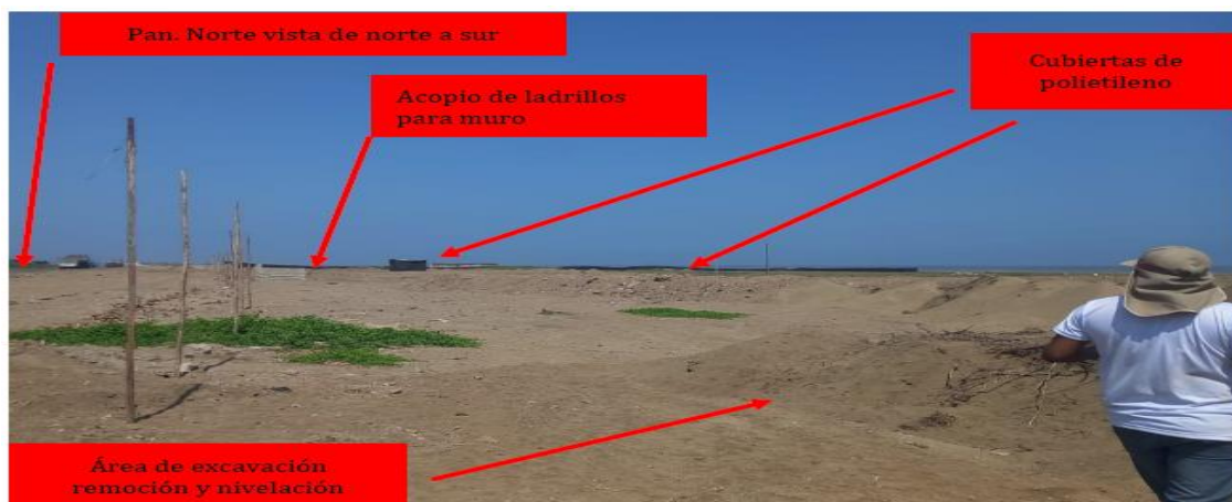
Imagen 11. Corresponde a la inspección de fecha 08.07.2023 del Informe N°000022-2023-PCDPC-SDDPCICI-DDC LIB-MLC/MC de fecha 13.07.2023 Imagen 8. Personal de la DDC durante inspección del día 08.07.2023 empezando inspección técnica. Nótese el alineamiento de palos, parte de material noble de construcción, cubiertas precarias con palos de madera y polietileno.
