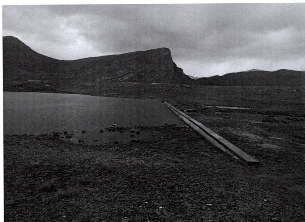
Imagen 9. Vista panorámica de muro de contención del dique, en el sitio arqueológico de Alalac. (inspección 10-04-2026)
