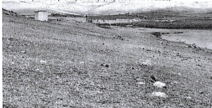
Foto 4. Vista de la construcción del dique de Tipicocha. (inspección 11/11/2025).
