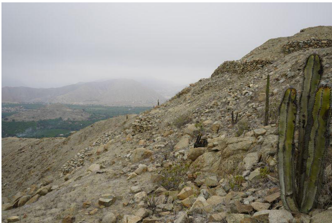
Imagen 15: Muros de contención ubicados en la cima del Sitio Arqueológico "San Cristóbal"
