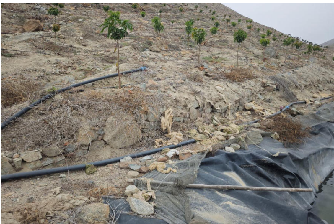
Imagen 10: Nótase la presencia de muros arqueológicos colindantes al reservorio de agua. Nótase la presencia de plantaciones y mangueras que viene afectando el sitio arqueológico "San Cristóbal".
