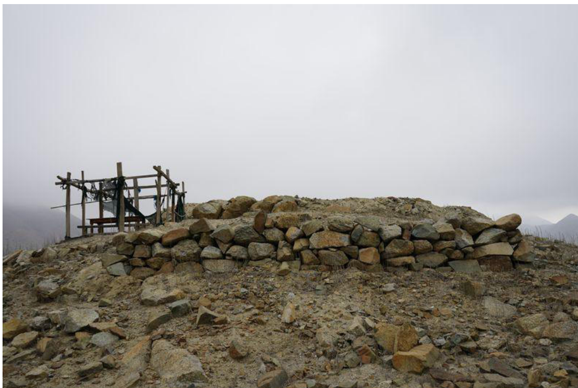
Imagen 19: Detalle del material y técnica constructiva de los muros de la cima del Sitio Arqueológico "San Cristóbal. Nótese la presencia de estructuras precarias superponiéndose a las evidencias arqueológicas.
