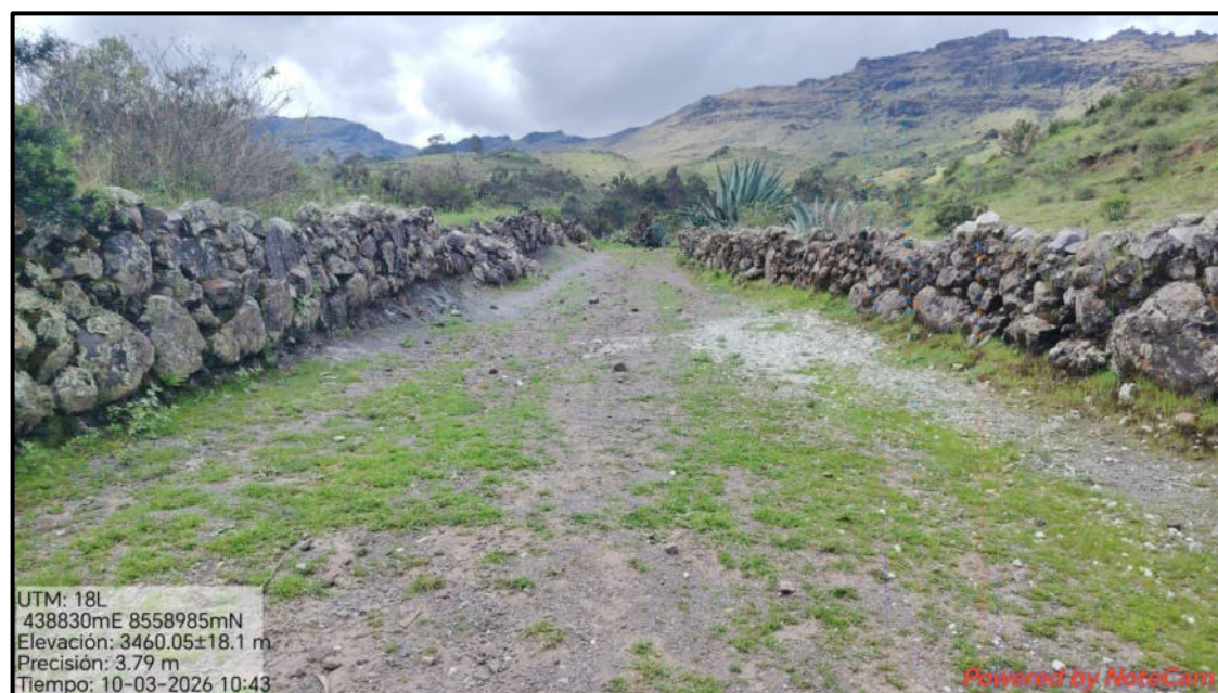
Imagen N° 06: Vista panorámica del camino prehispánico, se observa el detalle de su edificación, las calzadas están conjuntamente alineadas y adheridas con mortero de barro, este camino sigue siendo transitado por la población actual.
