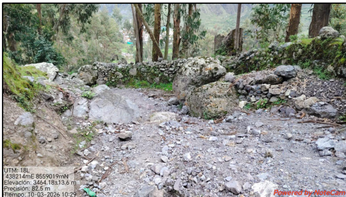
Imagen N° 03: Vista de los muros de contención realizados a doble pirca, calzados al suelo con mortero de barro, para la construcción se usaron piedras de río y de la zona.
