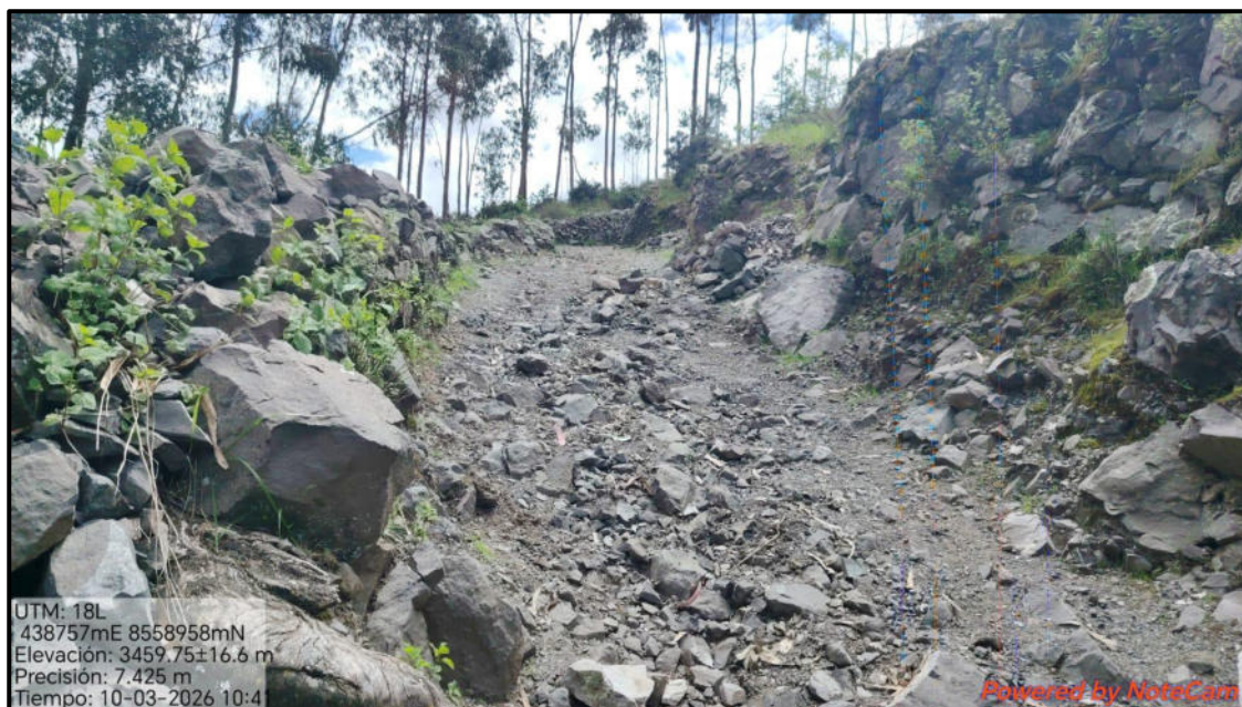
Imagen N° 05: Vista amplia del camino prehispánico, se observa los muros de contención en ambos lados, muros que son de doble pirca, además se ve el detalle de las formaciones rocosas, que están siendo usadas como soporte para el levantamiento de muros.
