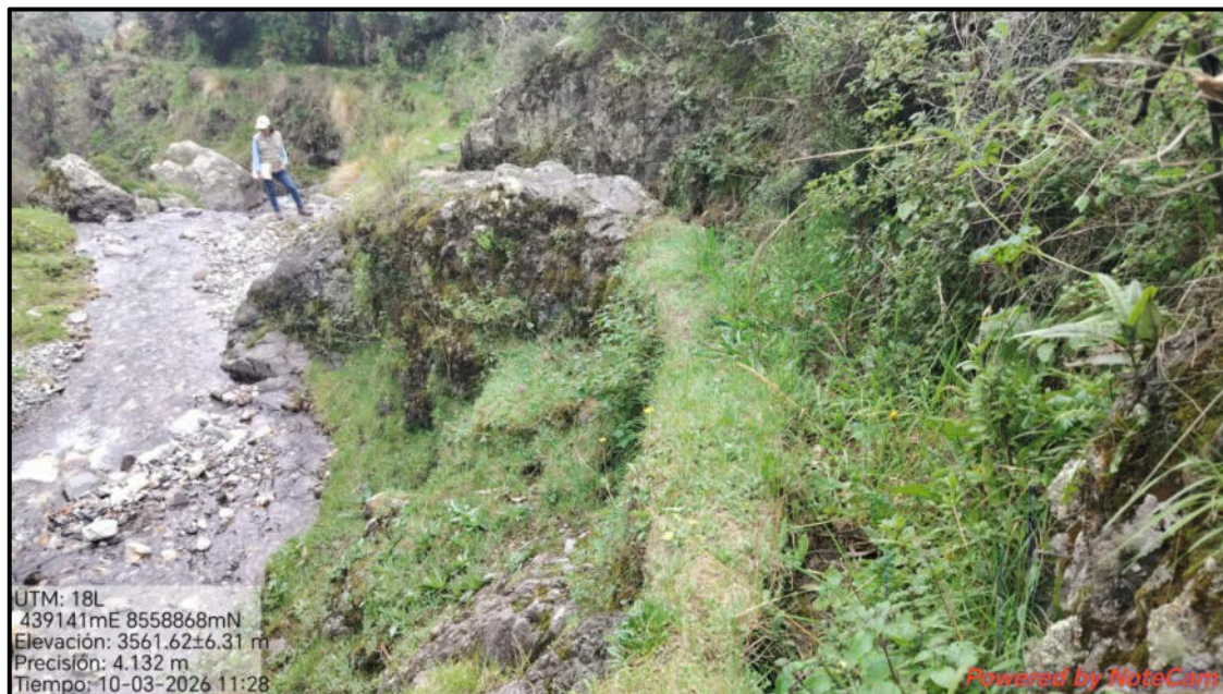
Fotografía N° 08: Vista de un alineamiento de piedras, estas realizadas al borde del riachuelo, su funcionalidad es la de un canal de agua, actualmente está cubierto por la vegetación.
