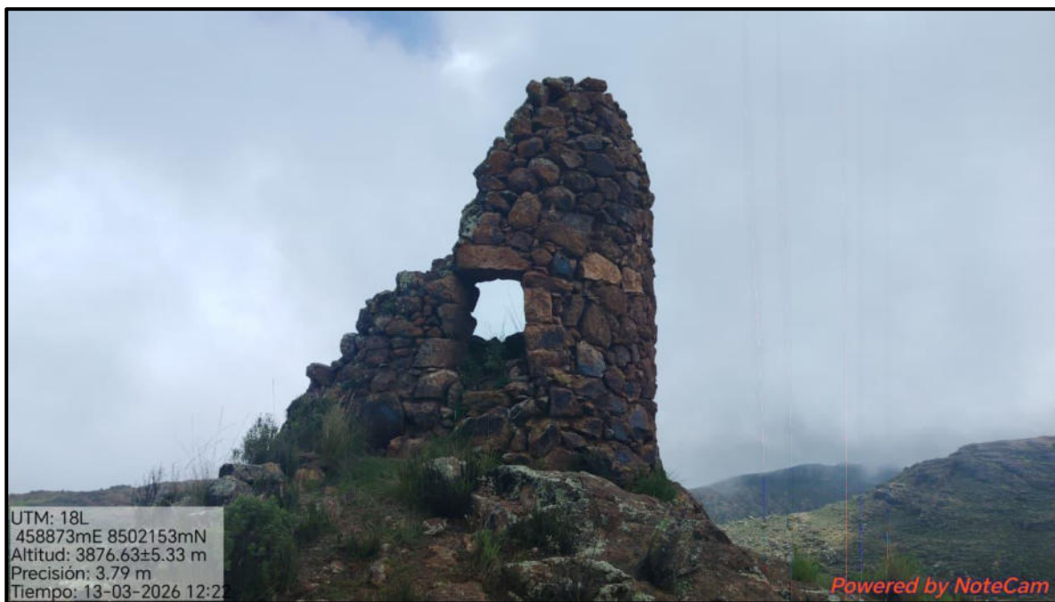
Imagen N° 04: Vista a detalle de una chullpa, presenta un acceso, esta edificación presenta un colapso, producto del abandono, es necesario solicitar la conservación.
