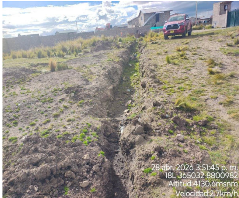
Fotografía 4. Vista de excavación para colocación de tuberías en el área del sitio arqueológico.
