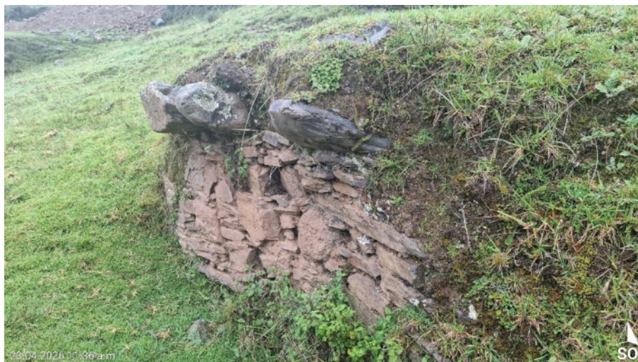
Fotografía 7. Vista del detalle constructivo del sitio arqueológico Tambomarka.
