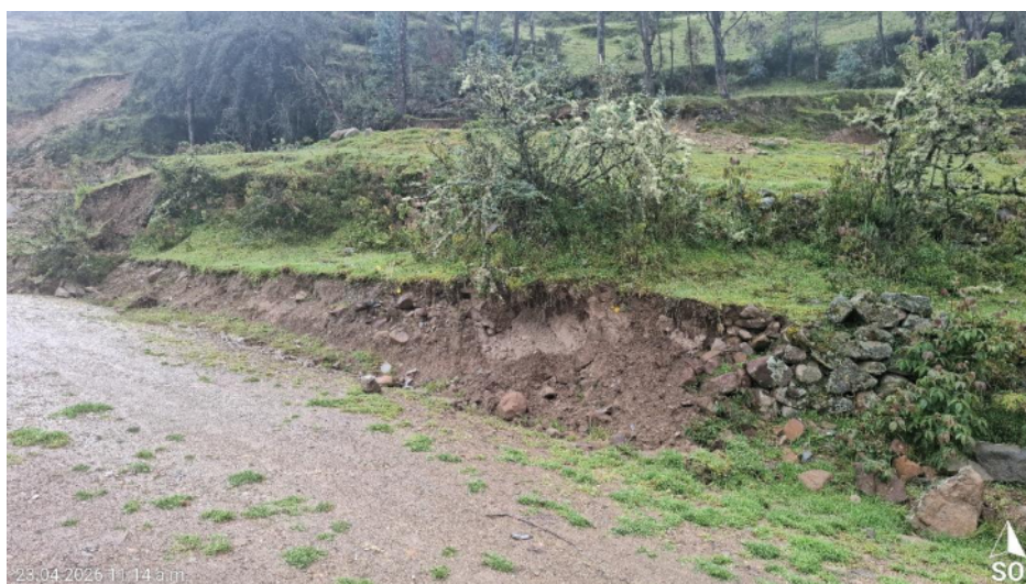
Fotografía 12. Vista de arquitectura prehispánica destruida por la construcción de la carretera.
