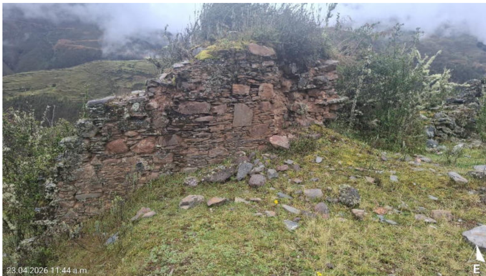
Fotografía 5. Vista del detalle constructivo del sitio arqueológico Tambomarka.
