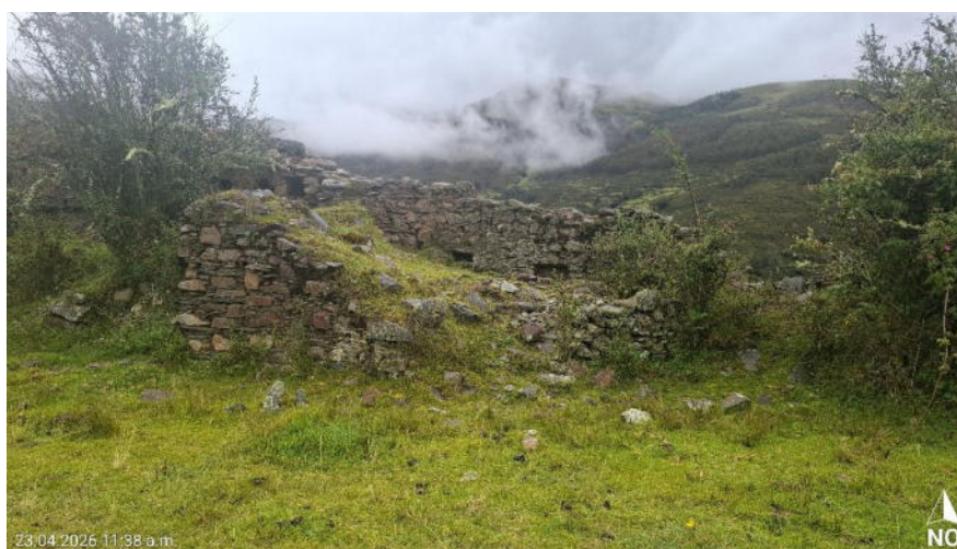
Fotografía 9. Vista del detalle constructivo del sitio arqueológico Tambomarka.
