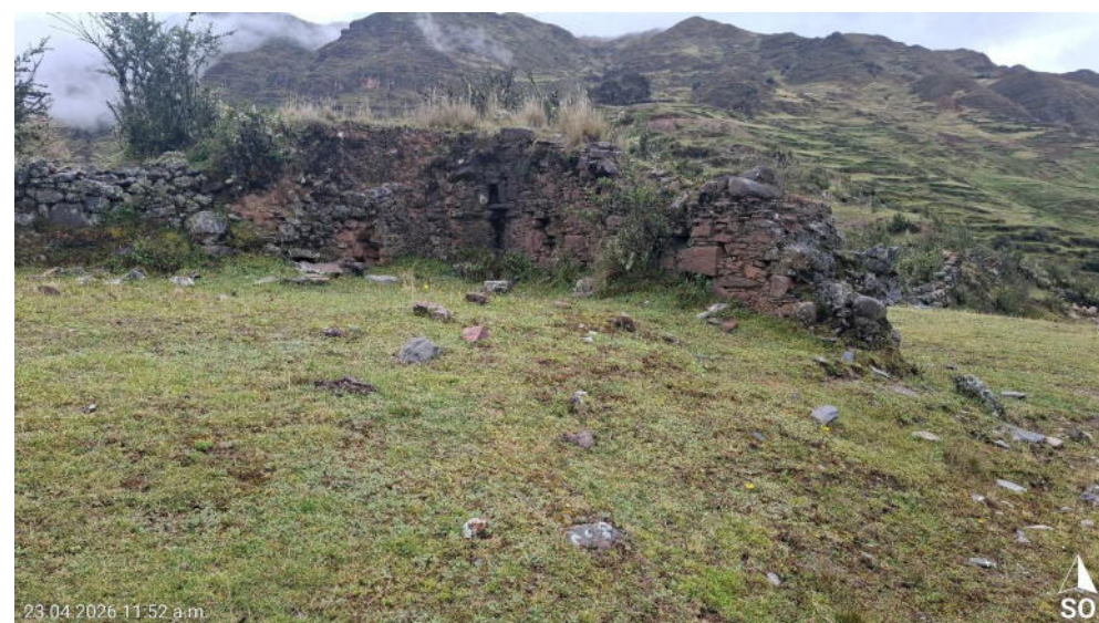
Fotografía 6. Vista del detalle constructivo del sitio arqueológico Tambomarka.
