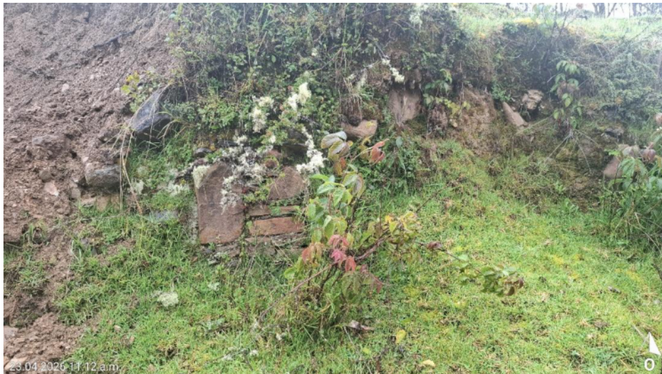
Fotografía 14. Vista de arquitectura prehispánica destruida por la construcción de la carretera.
