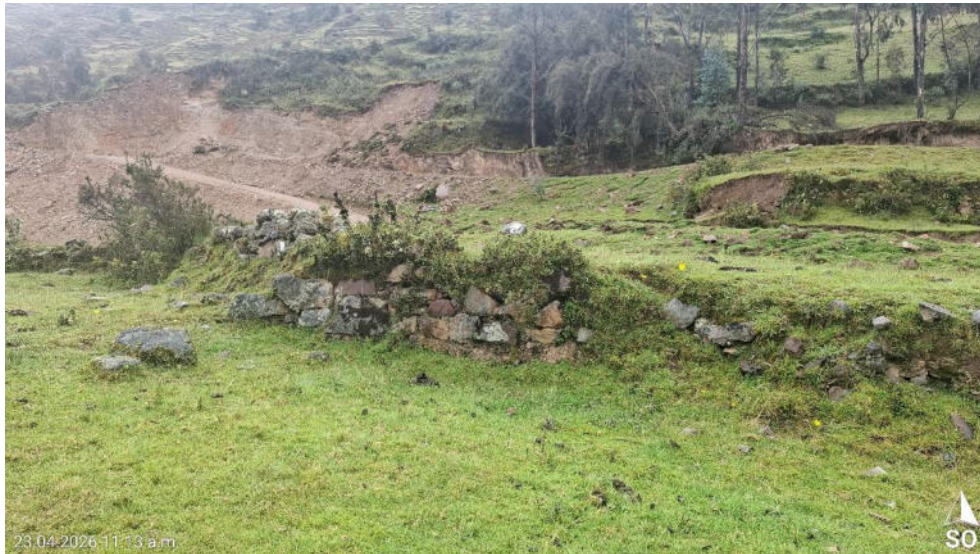
Fotografía 13. Vista de arquitectura prehispánica destruida por la construcción de la carretera.
