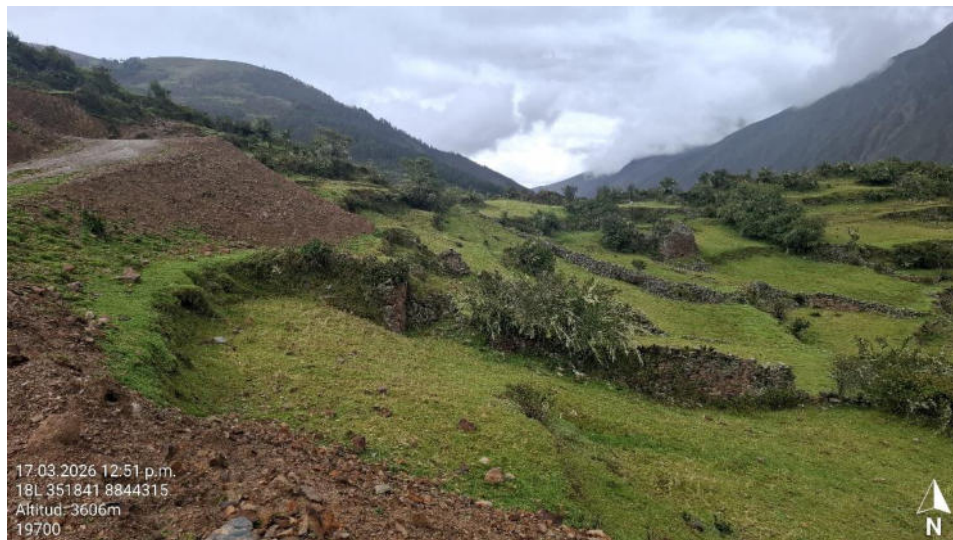
Fotografía 15. Vista de arquitectura prehispánica destruida por la construcción de la carretera.
