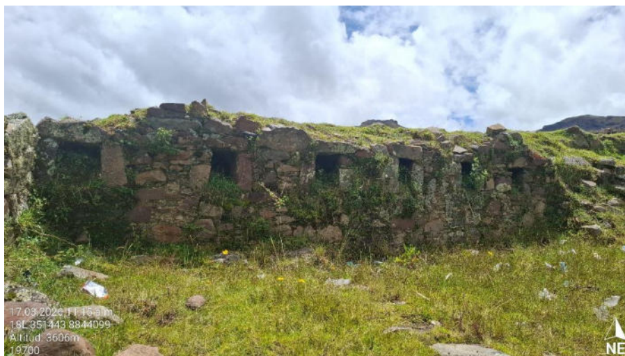
Fotografía 3. Vista del detalle constructivo del sitio arqueológico Tambomarka.
