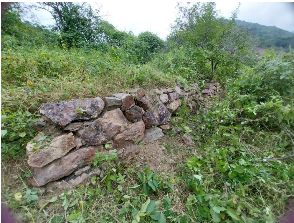
Foto N° [1]. Parte del muro de contención para nivelar una plataforma en la parte central del sitio. Registro de la DSFL 2023
