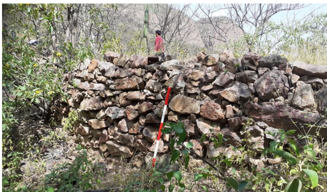
Foto N° [2] [Detalle del paramento del muro de contención que se usa para crear la rampa de acceso al altar ubicado sobre la cima de la roca] Prospección del 2022 a cargo del Lic. Alindor Rojas
