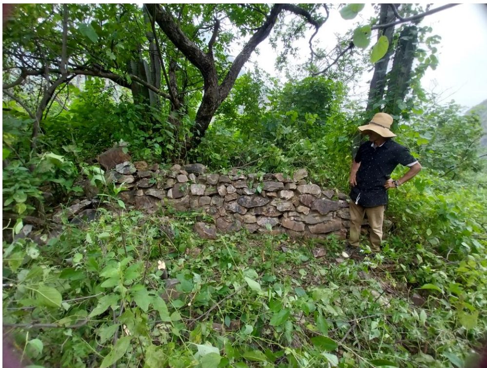
Foto N° [1]. [Desbroce de la arquitectura cubierta por la densa vegetación]. Registro 2023.
