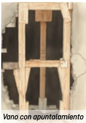
Vano de ingreso con apuntalamiento de madera
