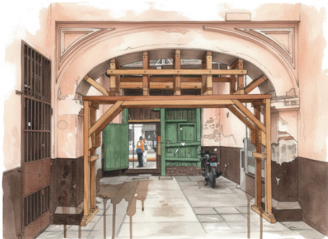
Vivienda con apuntalamiento de madera en el arco de medio punto.
