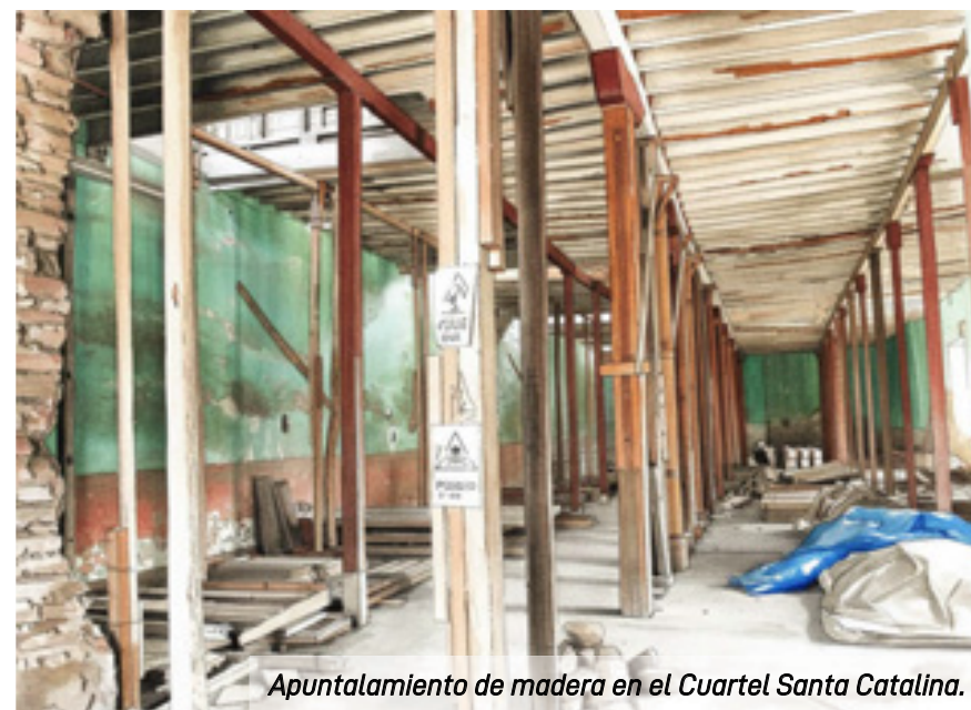
Interior con apuntalamiento de madera en el entrepiso.
