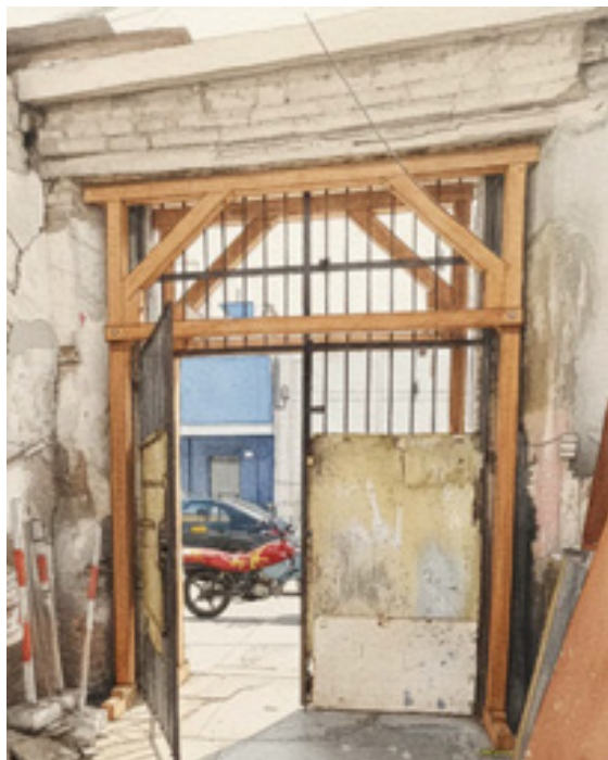
Vano de ingreso con apuntalamiento de madera
