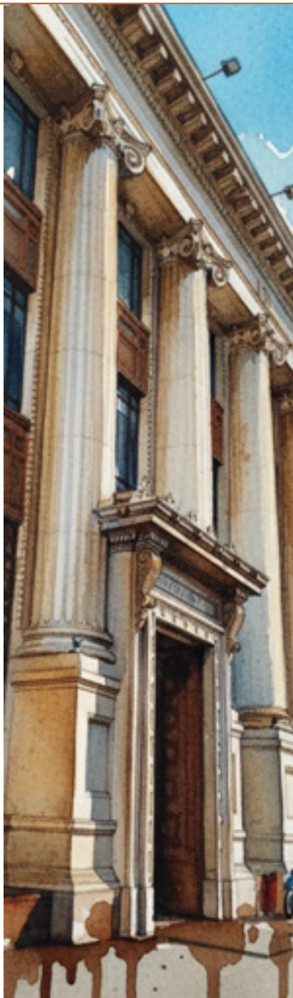
Banco de Crédito - Local Central. (Antiguo Banco Italiano)
