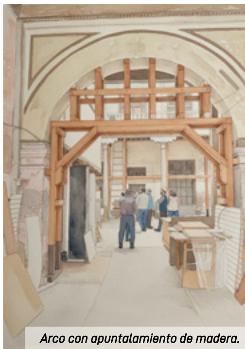
Vano de ingreso con apuntalamiento de madera
