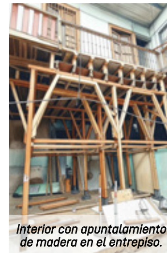
Ambiente interior con torres de apuntalamiento de madera.
