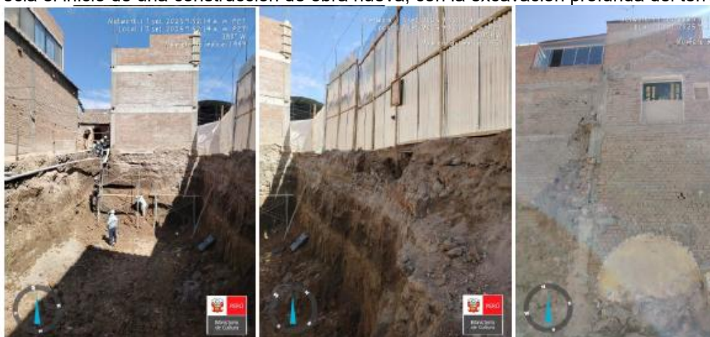
Imagen 7: Fotografía del interior del Monumento, correspondiente al 17.09.25, donde se aprecia el inicio de una construcción de obra nueva, con la excavación profunda del terreno
