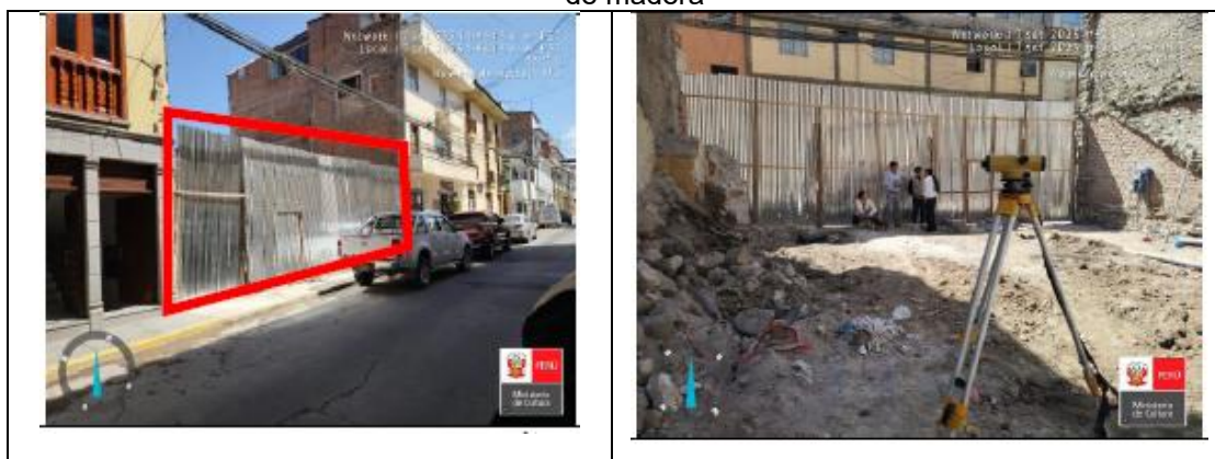
Imagen 6: Fotografías del inmueble, correspondientes al 17.09.25, donde se aprecia su demolición total y la instalación de un cerco provisional de calamina galvanizada y estructura de madera
