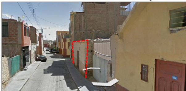
Imagen N.º 3: Fachada del inmueble antes de los trabajos no autorizados
