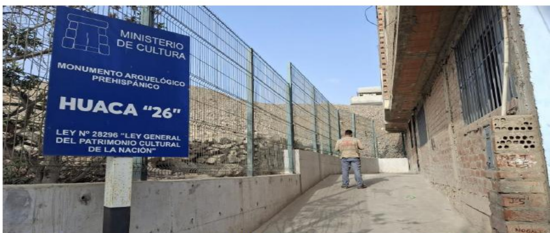
Foto 01: Vista del área materia de la denuncia sin acopio de materiales ajenos. Registro del 26.05.2026. Se visualiza el pavimento rígido.
