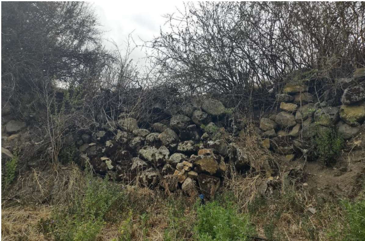
Imagen 04. Muro de contención registrado al lado este del sitio arqueológico de Huallhuay. Nótese sus dimensiones y estado de conservación.
