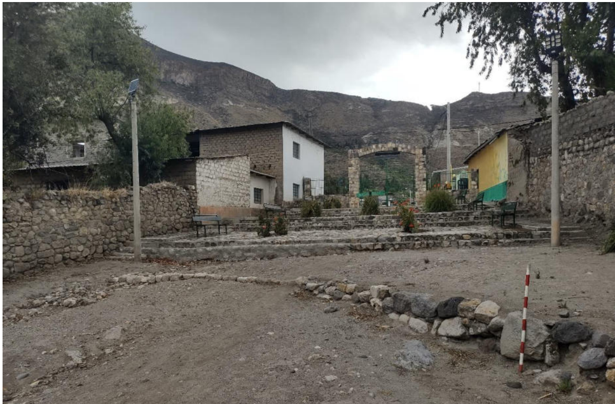
Imagen 11. Piso y escalinatas de piedras con concreto instaladas al lado oeste del sitio arqueológico de Huallhuay. Nótese las banquetas de metal y madera y los postes de luz.
