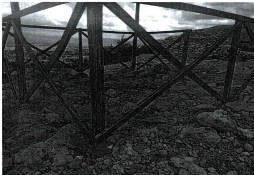
Imagen 5: material empleado en la construcción de la caseta de descanso y el uso del concreto armado para hacer parar las maderas (inspección 03/10/2025)
