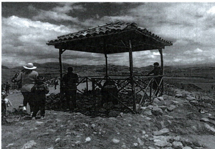
Imagen 4: instalación de una caseta de descanso. (inspección 03/10/2025)
