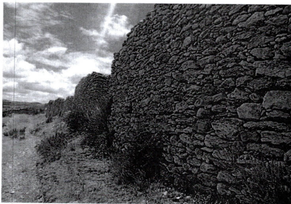
Imagen 18. Vista en detalle de la arquitectura prehispánica del sitio arqueológico de Arwaturu (inspección 03/10/2025)
