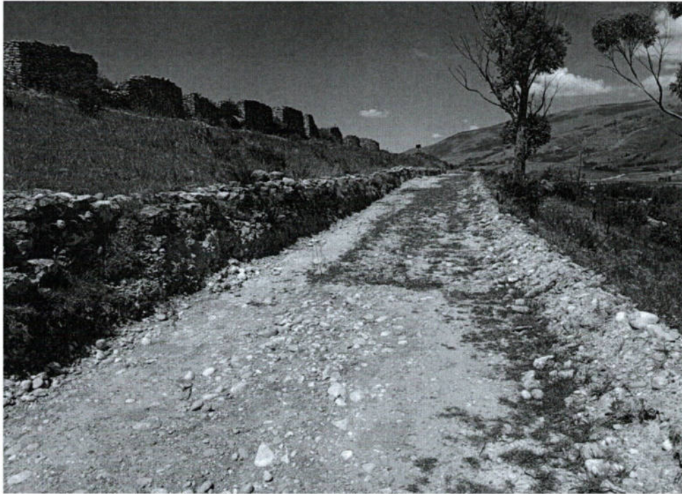
Imagen 4. Evidencia del ingreso de maquinaria (moto niveladora), para ampliar la trocha (remoción de tierra con maquinaria). (inspección 06-05-2026)
