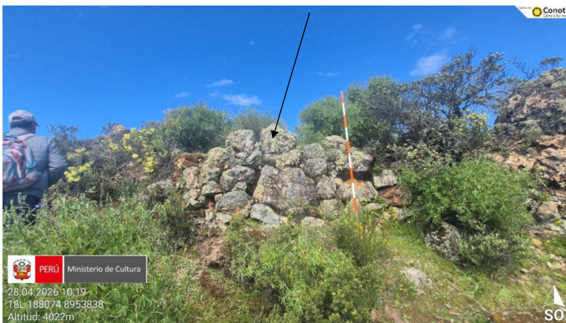
Imagen 06: vista de muro de piedra con técnica de pircado.
