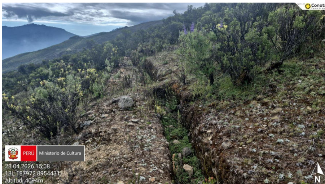
Imagen 02: vista a detalle de zanjas de filtración en la zona.
