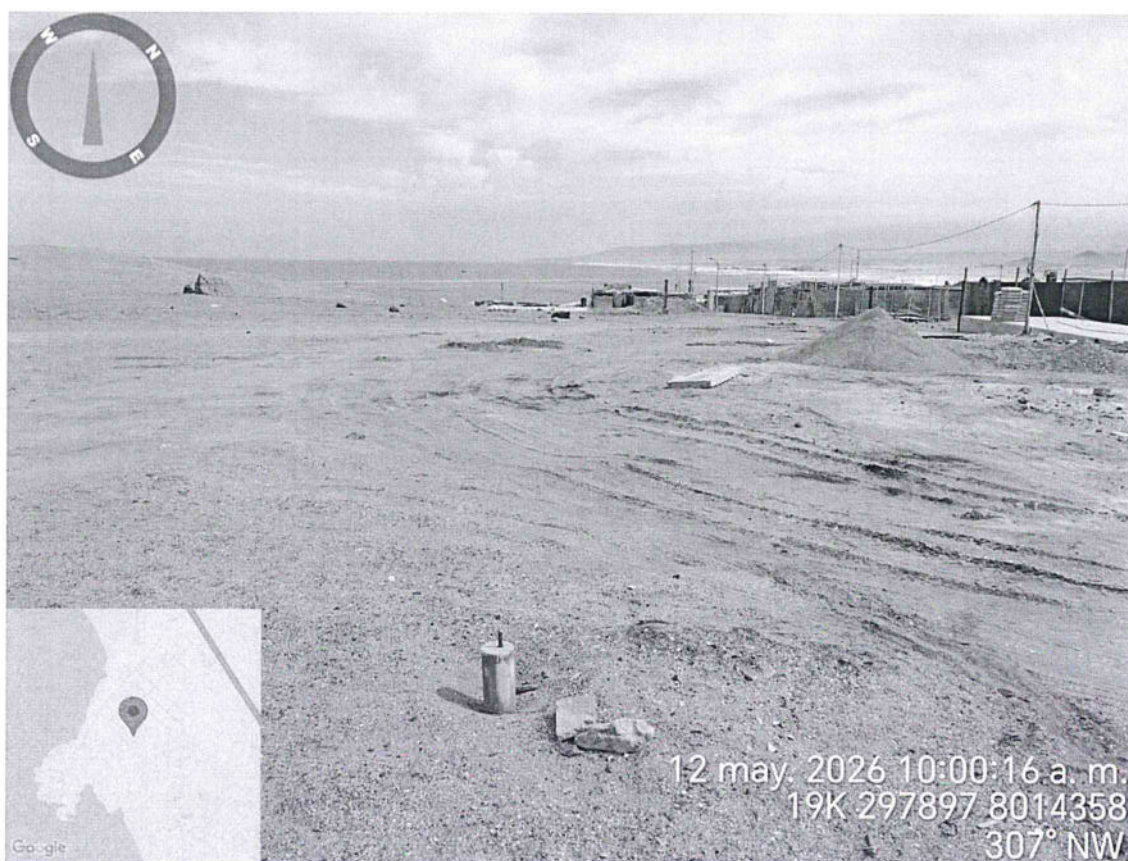
Foto N° 7: Vista Específica del área del sitio arqueológico Playa Meca Sector A ubicado ente el vértice 16 y vértice 17, donde se aprecia nivelación de terreno.
