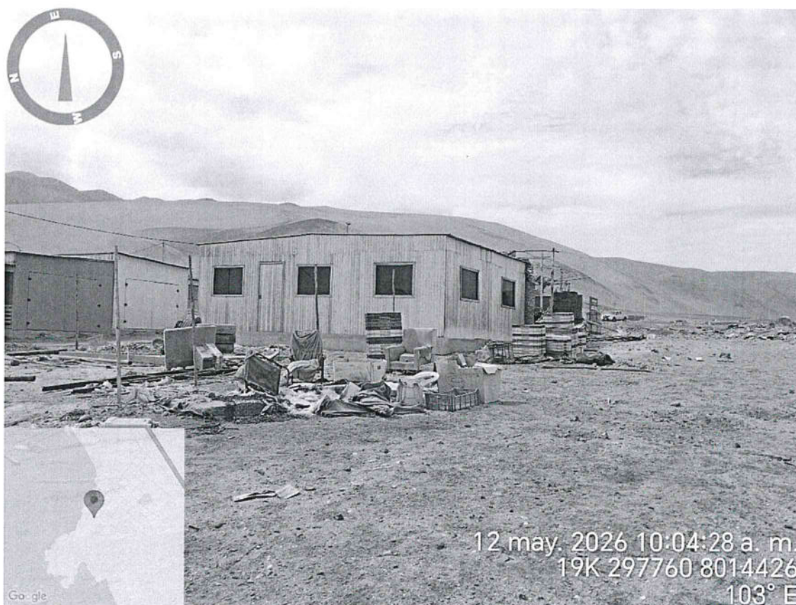
Foto N° 4: Vista a detalle de las viviendas provisionales colindantes con el polígono del sitio arqueológico Playa Meca Sector A. Notese la acumulación de material disperso en la zona.
