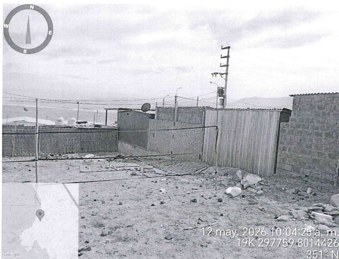
Foto N° 2: Vista a detalle de las viviendas provisionales colindantes con el polígono del sitio arqueológico Playa Meca Sector A
