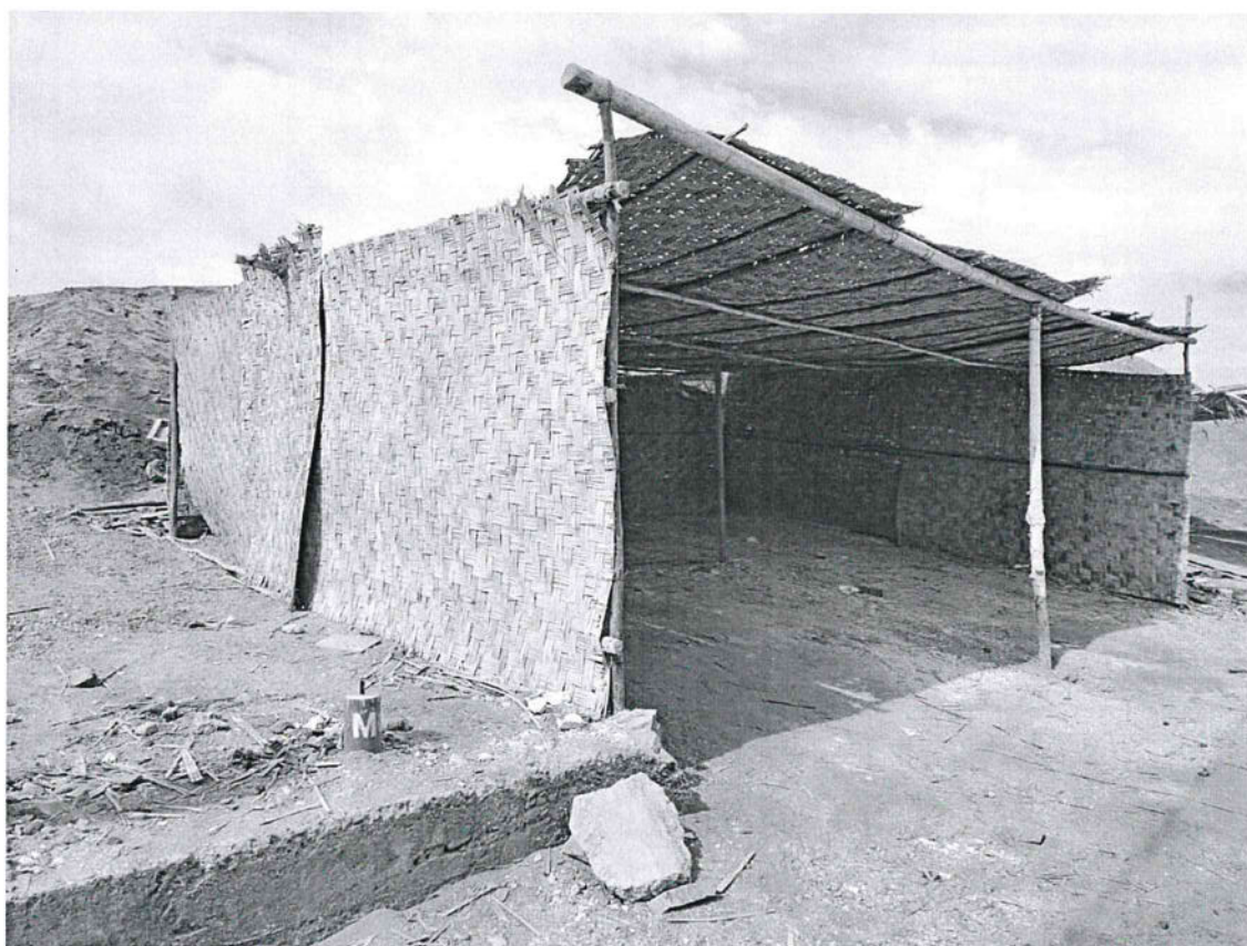
Foto N° 6: Vista a detalle de una estructura temporal levantada con esteras, la cual está siendo usada como cochera al interior del polígono del sitio arqueológico Playa Meca Sector A
