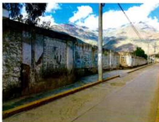
Fotografía actual del exterior del inmueble (fachada). Se observa muro de un solo nivel, con vanos tapiados. Fuente: AGORA S.D.
