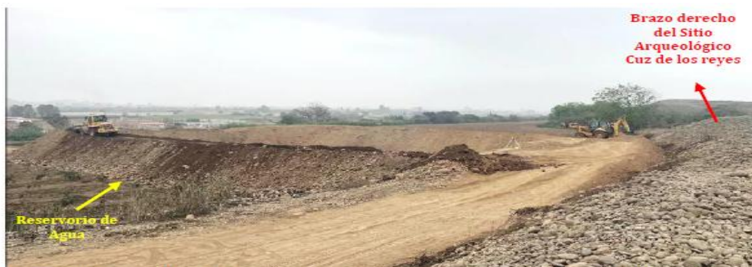
Foto 2: Sitio Arqueológico Cruz de los Reyes, se aprecia una vista panorámica donde se aprecia 2 maquinarias pesadas (excavadora y Retroexcavadora) en plena faena de construcción de un reservorio para contener agua (Foto 3, tomado del Informe Técnico N° 000056-2025-DCS-DGDP-VMPCIC-DFAMC).
