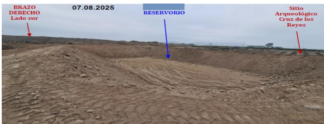
Foto 17: Sitio Arqueológico Cruz de los Reyes, se aprecia la construcción en proceso de un reservorio de forma pirámide truncado invertido para almacenar agua al sur del Brazo Derecho
