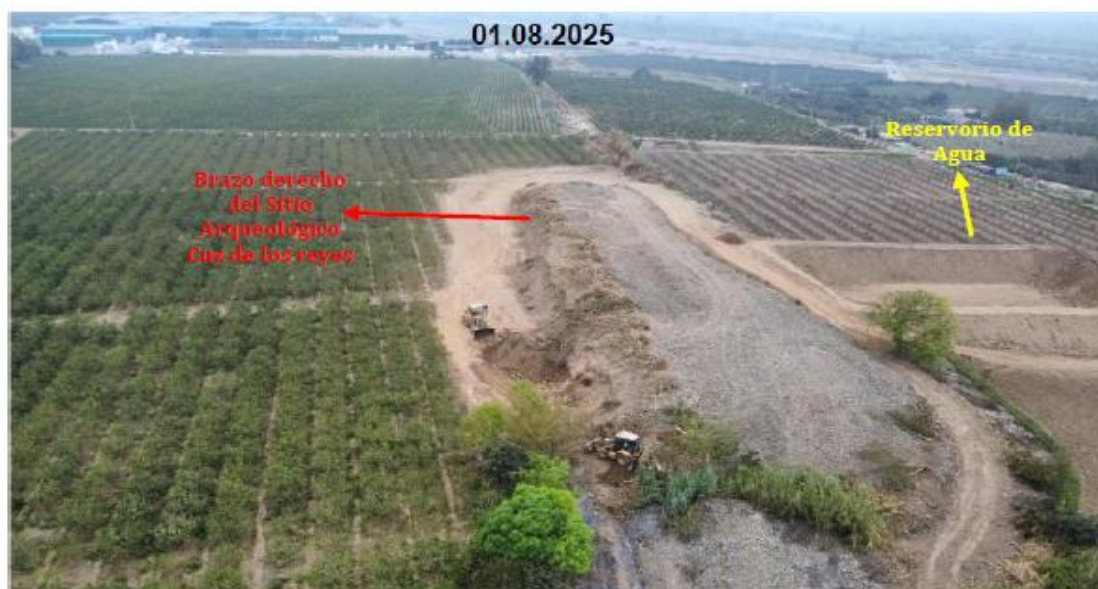
Foto 1: Sitio Arqueológico Cruz de los Reyes, se aprecia una vista panorámica donde se aprecia al Brazo Derecho y 2 maquinarias pesadas (excavadora y Retroexcavadora) en plena faena de remoción dañando el brazo sur y a un costado un reservorio para contener agua (Foto 1, tomado del Informe Técnico N° 000056-2025-DCS-DGDP-VMPCIC-DFA/MC).
