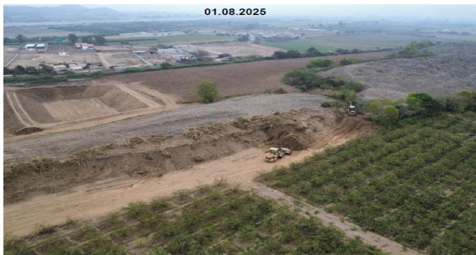
Foto 2: Sitio Arqueológico Cruz de los Reyes, se aprecia una vista panorámica donde se aprecia al Brazo Derecho y 2 maquinarias pesadas (excavadora y Retroexcavadora) en plena faena de remoción dañando el brazo (CASO 1) y a un costado un reservorio para contener agua (Caso 2). Y se ubica en el interior de la poligonal intangible. Foto tomado con un DRON el 01 de agosto de 2025 (adjunta en el documento de la referencia "j").
