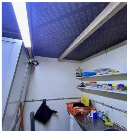
Imagen 3: Vista del ambiente ampliado en la parte posterior acondicionado para uso de cocina. Fuente: Inspección DCS 24/09/2025
