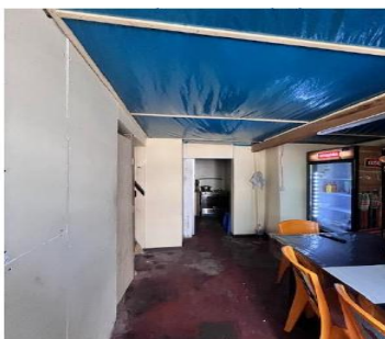
Imagen 2: Vista del primer ambiente del inmueble. Fuente: Inspección DCS 24/09/2025
