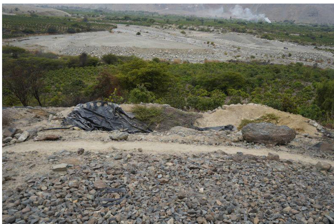
Imagen 10: Cerca al panel informativo se registro la excavación de un reservorio de agua
