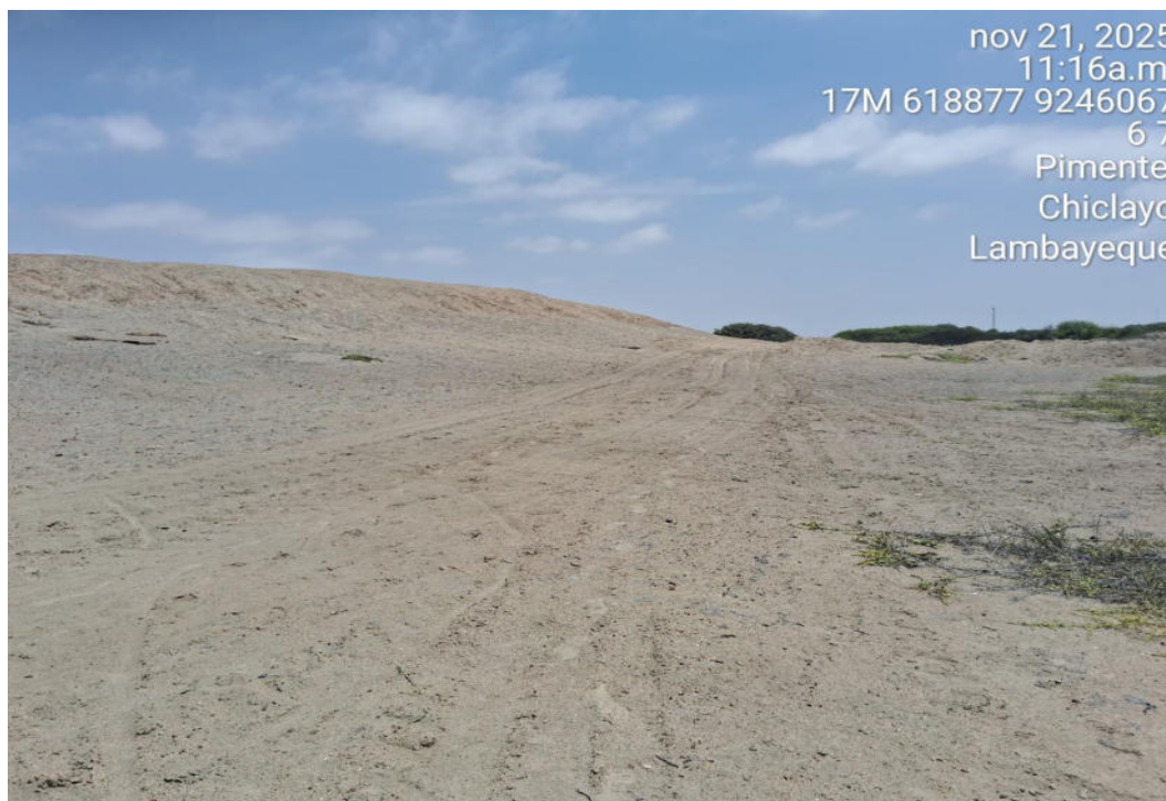
Imagen N°02: fotografía de la remoción de tierra para fines adaptación de una tocha carrozable.
