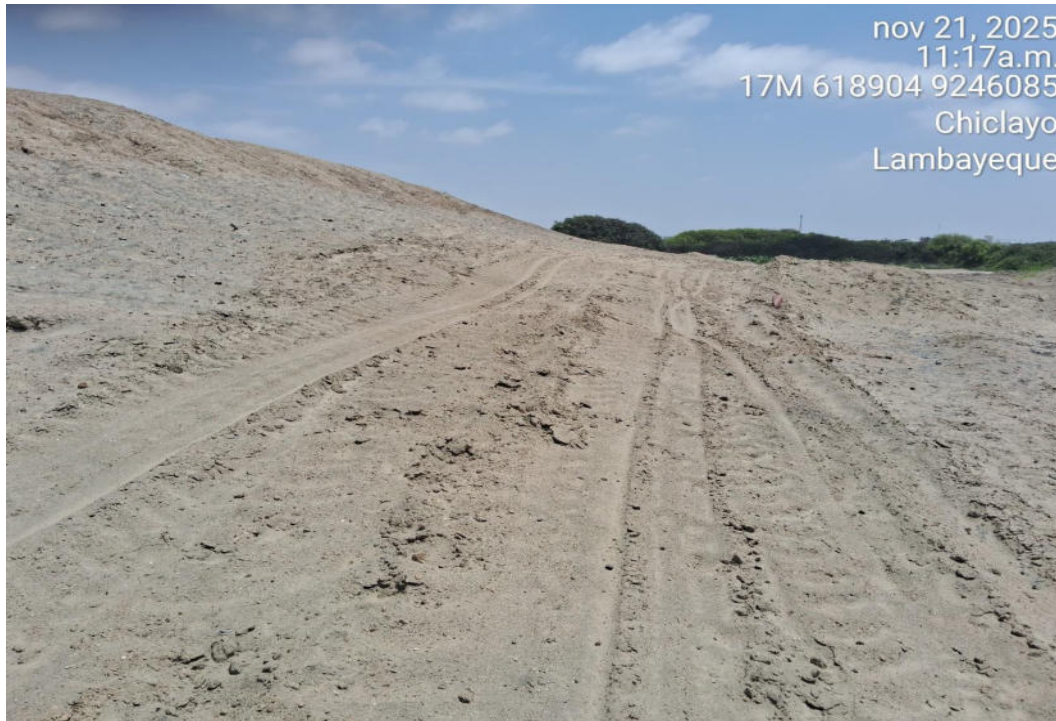
Imagen N°03: fotografía de la remoción de tierra para la apertura de una trocha carrozable.
