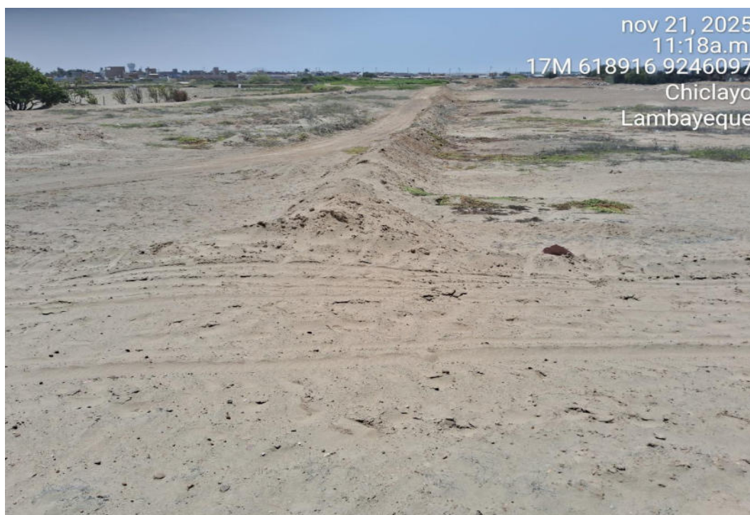
Imagen N°04 fotografía de la afectación, próximo al BIP.
