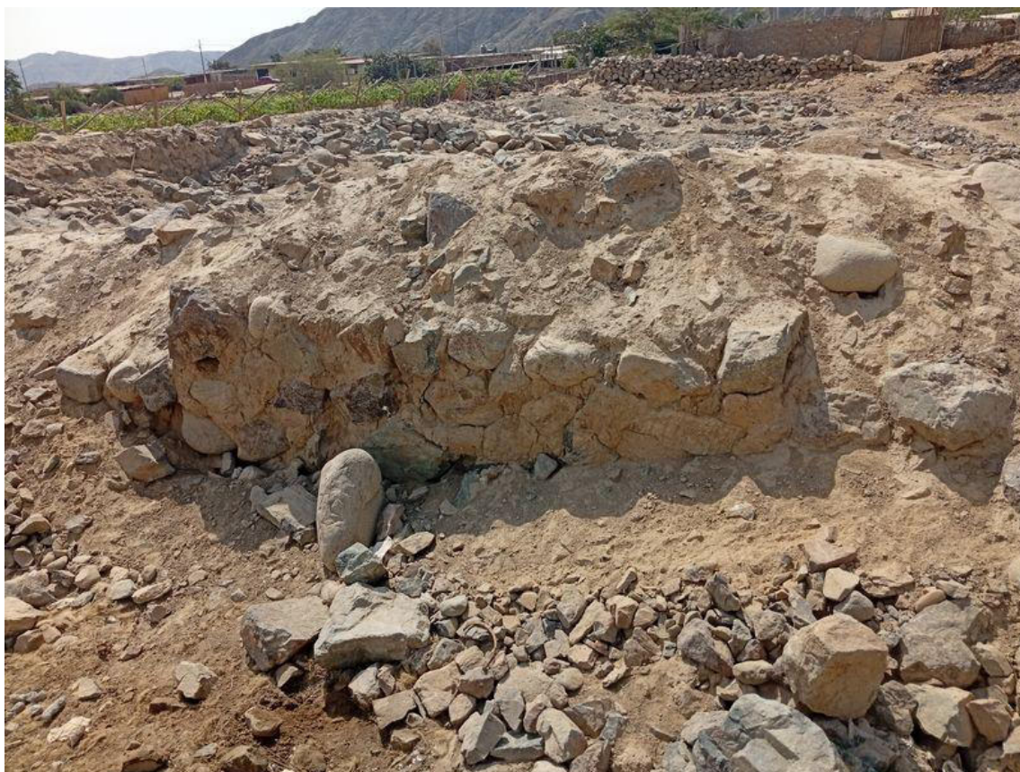
Imagen 09: Detalle del material y la técnica constructiva de los muros del Sitio Arqueológico “Cahuachuco”.
