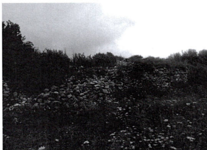
Imagen 6. Vista panorámica de la terraza en proceso de colapso en el sitio arqueológico de Coto Ulo (inspección 17-04-2026)
