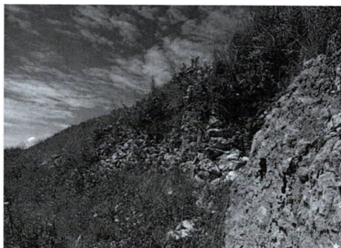
Imagen 10. Evidencia donde se observa parte de la terraza en colapso por factores climáticos. (inspección: 17-04-2026)
