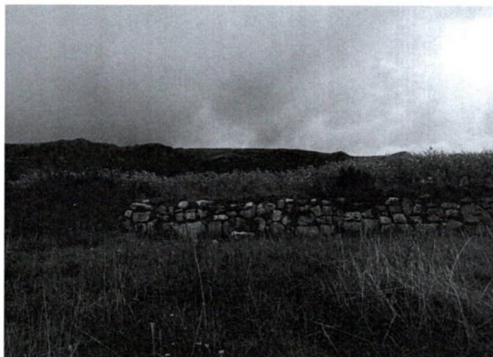
Imagen 8. Vista en detalle de la terraza con reúso. (inspección 17-04-2026)
