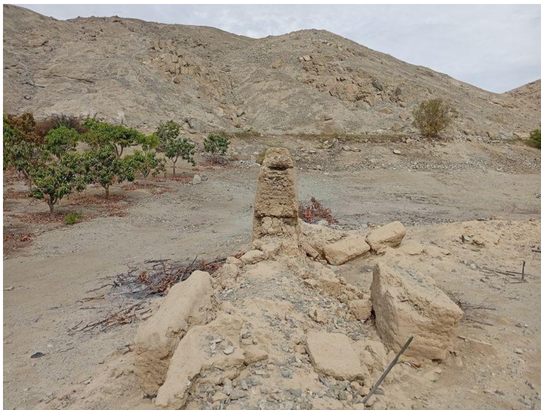
Imagen 05: Detalles de los muros de tapia dentro del Sector A del Sitio Arqueológico "San Jerónimo". Nótese la afectación y la presencia de quemas modernas al interior del sitio.
