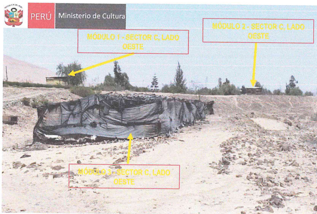
Foto N° 11: Se aprecia instalaciones prefabricadas de estera, módulo de madera y malla arpillera en las inmediaciones de terreno en expansión agrícola dentro del polígono del Paisaje Cultural Arqueológico Complejo Miculla – Pachia, Sector “C” (AREA 2). Foto tomado el día 26.03.2026.
