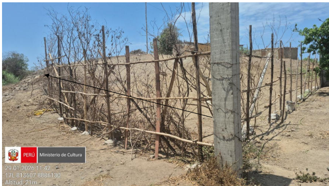
Imagen 03: vista de la instalación de cerco de palos con base de cemento y quincha de guarango.
