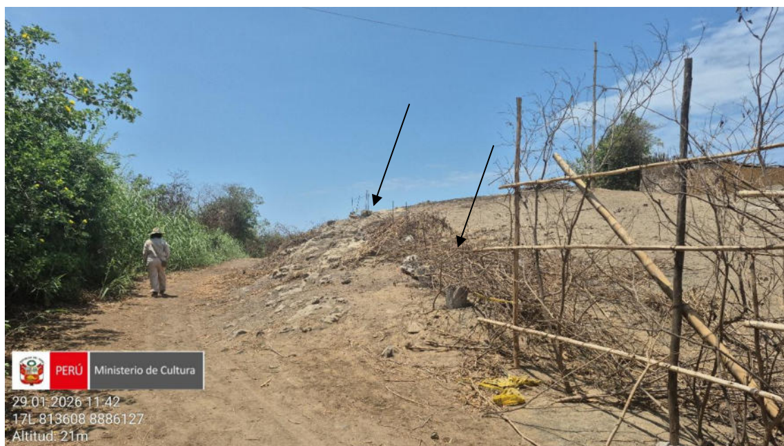
Imagen 04: instalación de cerco con varilla de fierro y alambre de púa
