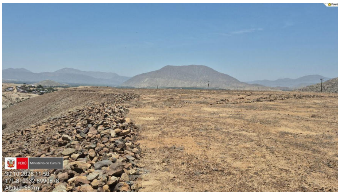
Imagen 04: vista panorámica de la remoción del suelo.
