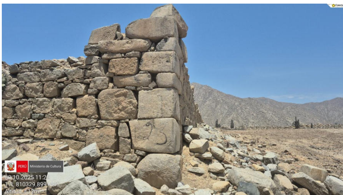
Imagen 06: muro arquitectónico con piedras de bloques líticos, así como en parte presenta la unión con argamasas de barro.
