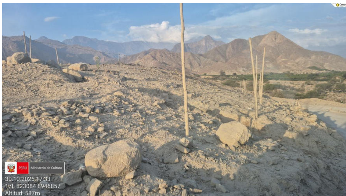
Imagen 07: instalación de cerco de palos.
