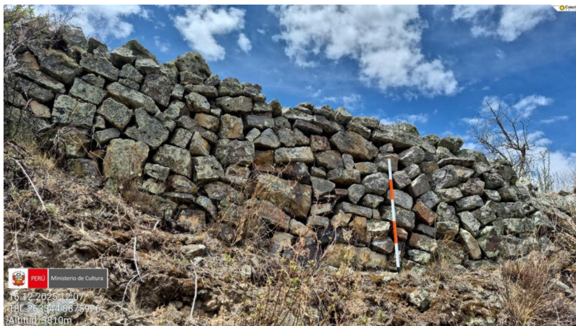
Imagen 07: vista del muro prehispánico construidos con técnica de pircado con aparejo irregular.
