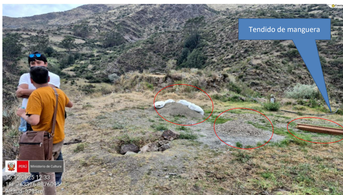
Imagen 02: vista panorámica de cumulo de material agregado y de material de madera en zona intangible
