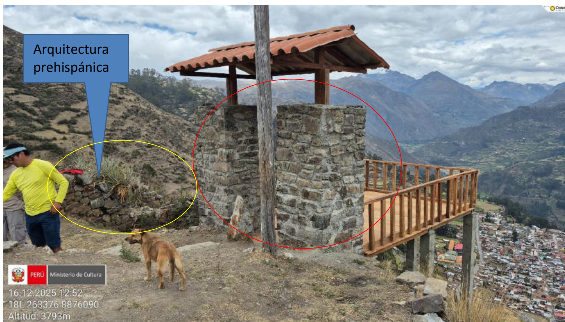
Imagen 04: vista panorámica de la construcción de dos muros de piedra unidas con cemento
