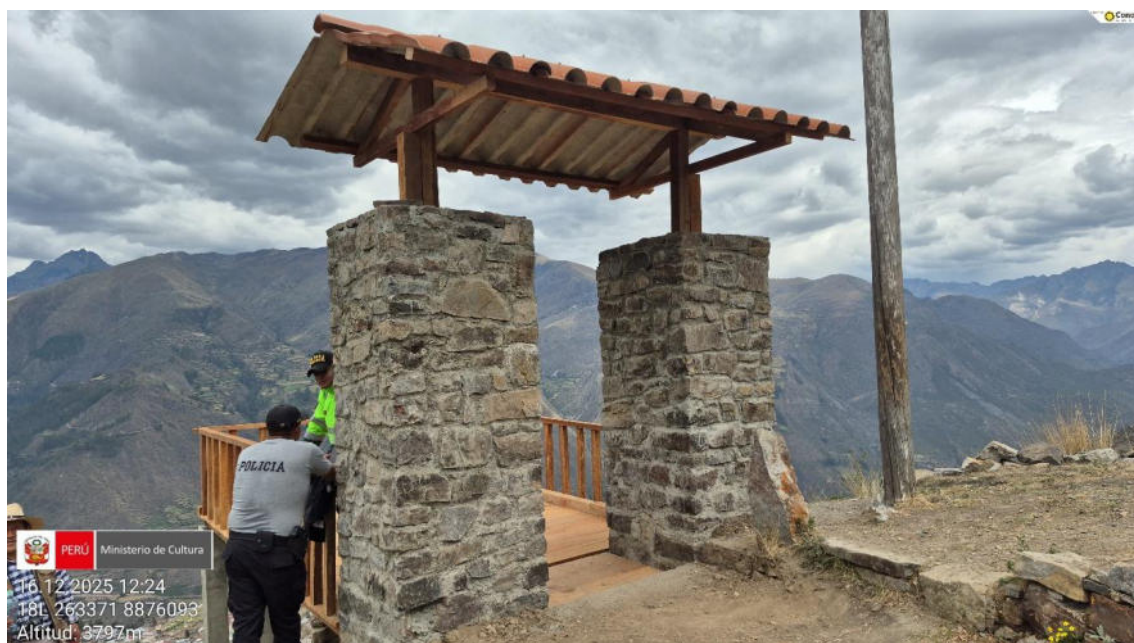
Imagen 03: vista panorámica de muros de piedra con cemento y techo con tejas andina.
