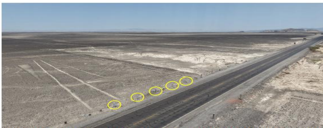
Fig. 04: Véase el tramo de 25 metros lineales aproximados de los hitos de cemento pintados de blanco, que corresponderían a la reposición indicada en la Carta S/N del 27 de enero de 2006. Nótese en círculo los hitos repuestos.
