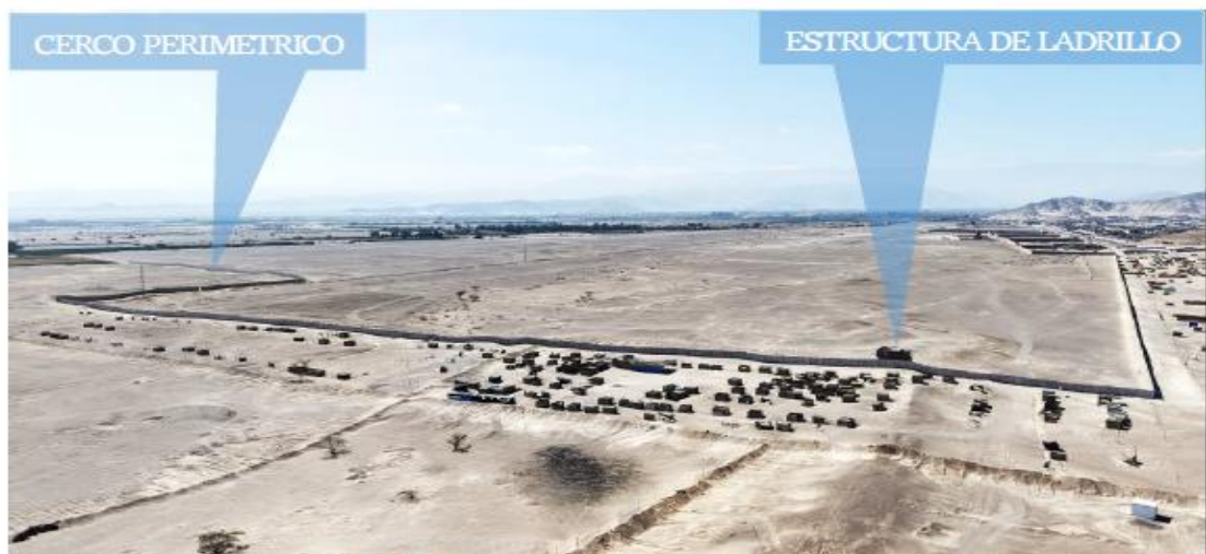
Fig. 06: Véase la ampliación del cerco perimétrico, de aproximadamente 2 km de bloques de concreto.
