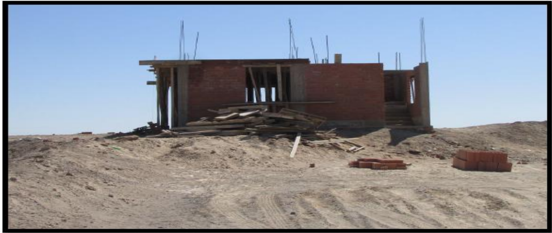
Foto 04. Se observa una construcción de material noble.
