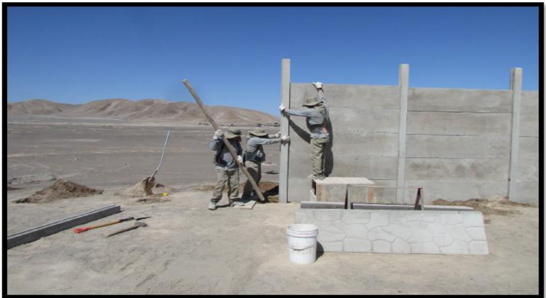
Foto 08. Se observa a personal obrero colocando las columnas y plaquetas de concreto.
