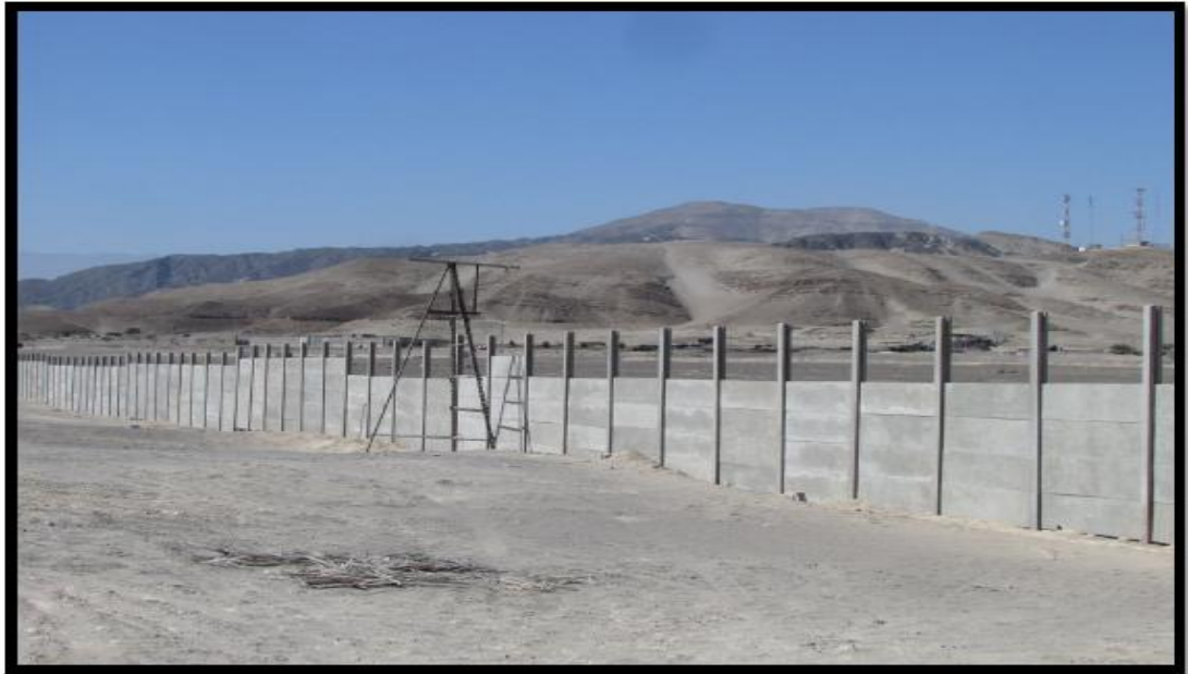
Foto 07. Cerco perimétrico, compuesto por plaquetas de concreto.
