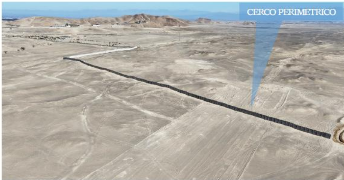
Fig. 07: Véase la ampliación del cerco perimétrico, de aproximadamente 2 km de bloques de concreto.
