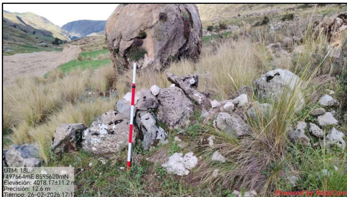
Imagen N° 07: Vista de las cabeceras de muro, estas se prolongaron hasta el corte realizado por la intervención antrópica.
