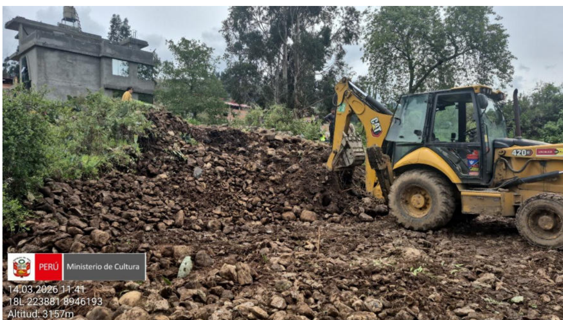
Imagen 04: vista a detalle de la excavación del terreno.
