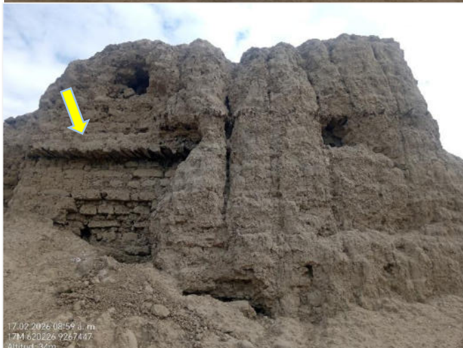
Foto 3. Vista en detalle donde se observa entre los muros de adobe una disposición horizontal de palos de algarrobo. Vista de sur a norte.
